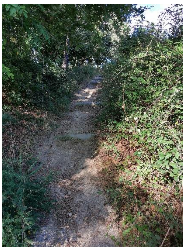
Caminho que dá acesso à parte superior do túnel
