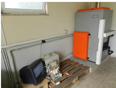
Figura 3-18 Local e equipamentos utilizados na análise térmica
