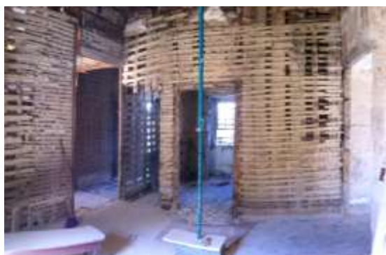
c) Paredes de tabique simples, Ed.2
