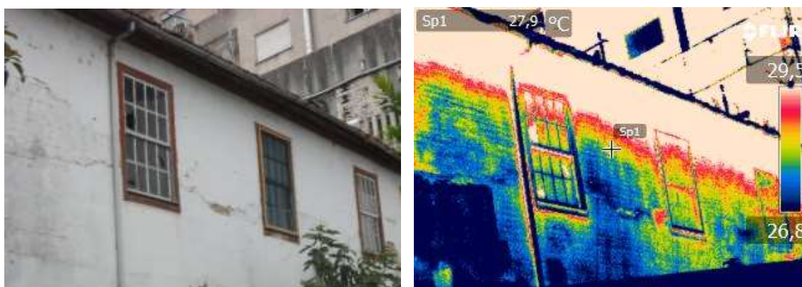
Figura 4-47: Fachada principal do CE.1 e o respetivo termograma obtido
