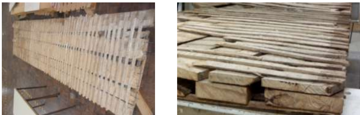
Figura 5-6: Parede de tabique dupla
