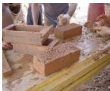
b) Molde para execução dos blocos de adobe, (Cepeda, 2009)
