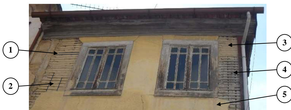
Legenda: 1- Fasquio; 2- Tábua vertical; 3- Enchimento; 4- Pregos; 5- Revestimento
