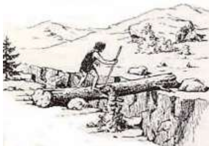
Figura 2-2: Ponte rudimentar (Silva, 2005)
