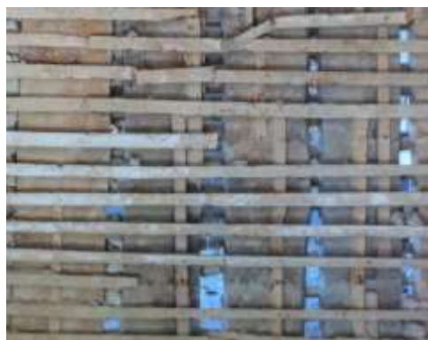
Figura 4-15: Colocação de ripas na vertical para nivelar o conjunto da parede de tabique
