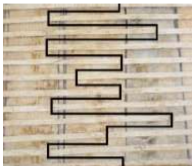
Figura 5-3: Desalinhamento das emendas das ripas de uma parede de tabique
