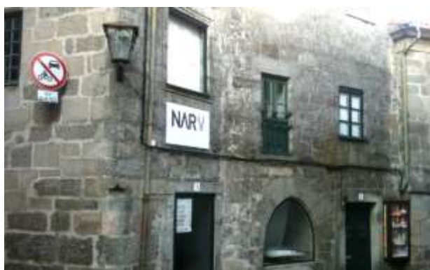
Figura 4-16: Fachada principal do edifício
