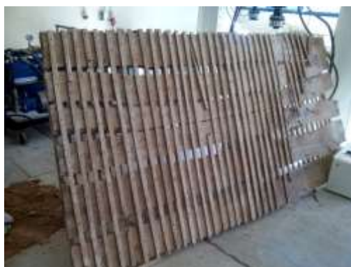
Figura 5-4: Parede de tabique simples
