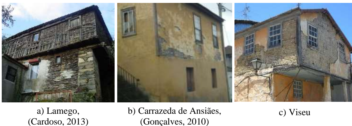
Figura 3-3: Construções em tabique em Portugal
