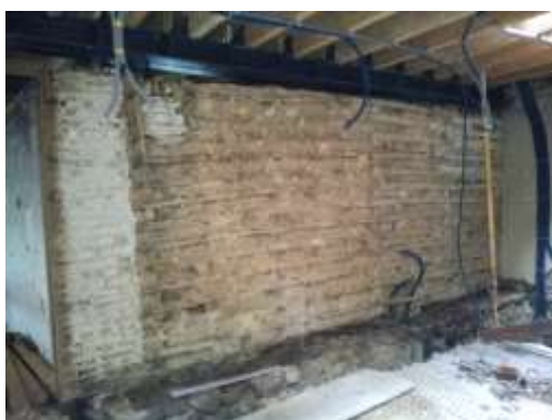
a) Antes do restauro
