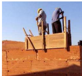
b) Compactação de uma parede de taipa, (Carvalho, 2006)
