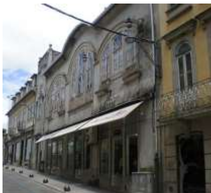
Figura 4-1: Fachada principal do edifício Ed.1
