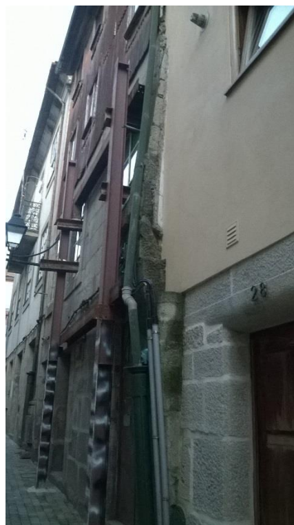
Figura 2.15: Deformação dos elementos de suporte
