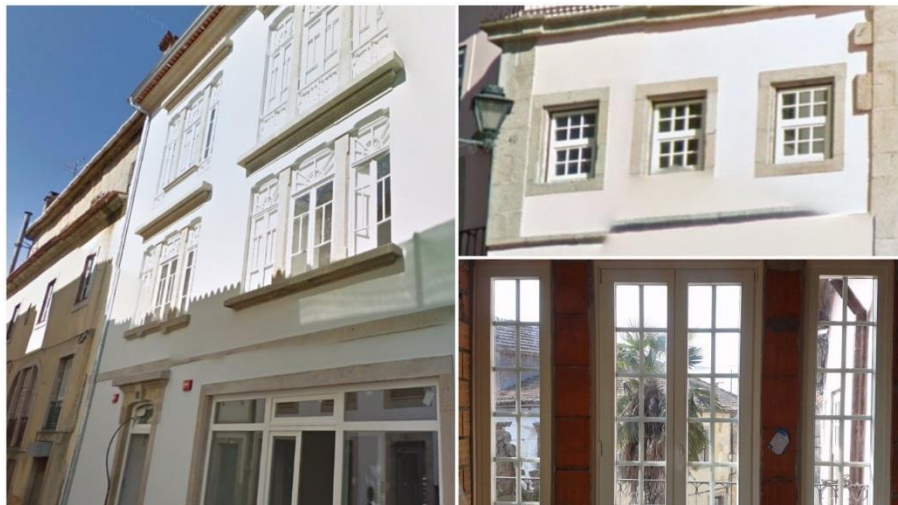
Figura 5.22: Edifícios do quarteirão 1 e 2 com réplicas das janelas originais
