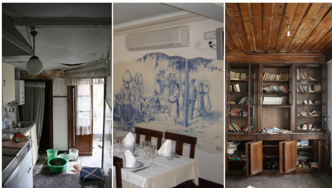
Figura 4.10: Pormenores do interior dos edifícios do quarteirão 2
