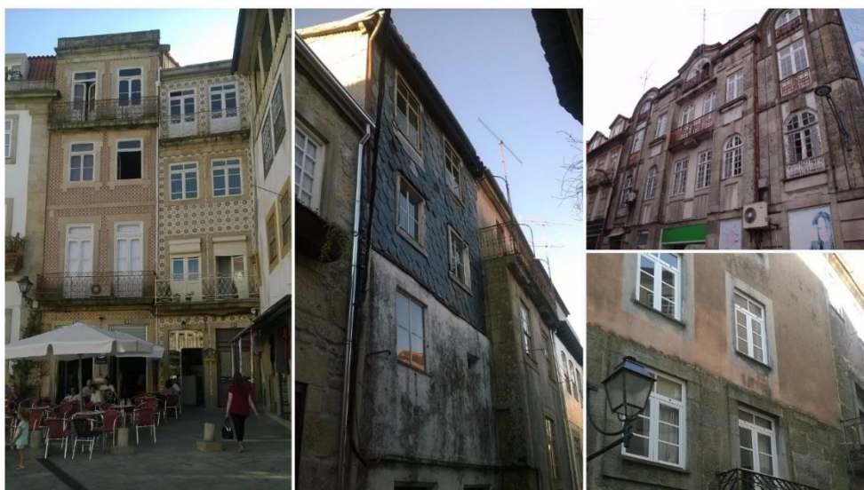
Figura 5.19: Diferentes revestimentos exteriores em parede de fachada
