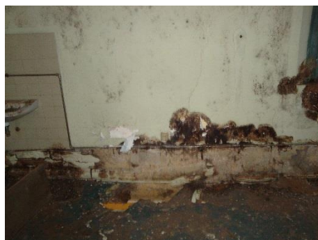
Figura 2.61: Destaque do material do rodapé
