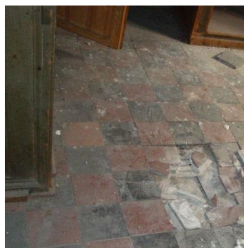
Figura 2.40: Descolagem do material cerâmico
