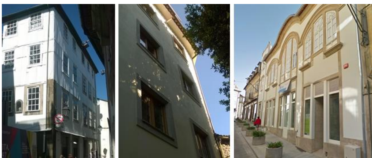
Figura 3.9: Edifícios em boas condições (Devoluto, Novo e Reabilitado, por esta ordem)
