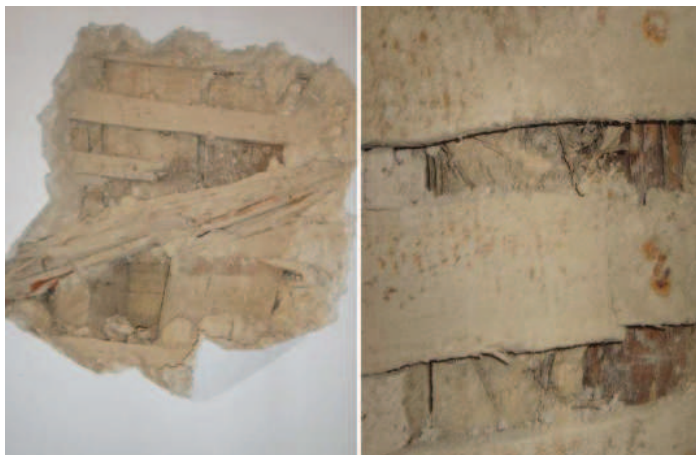
Figura 3-5: Travamento das paredes de tabique
