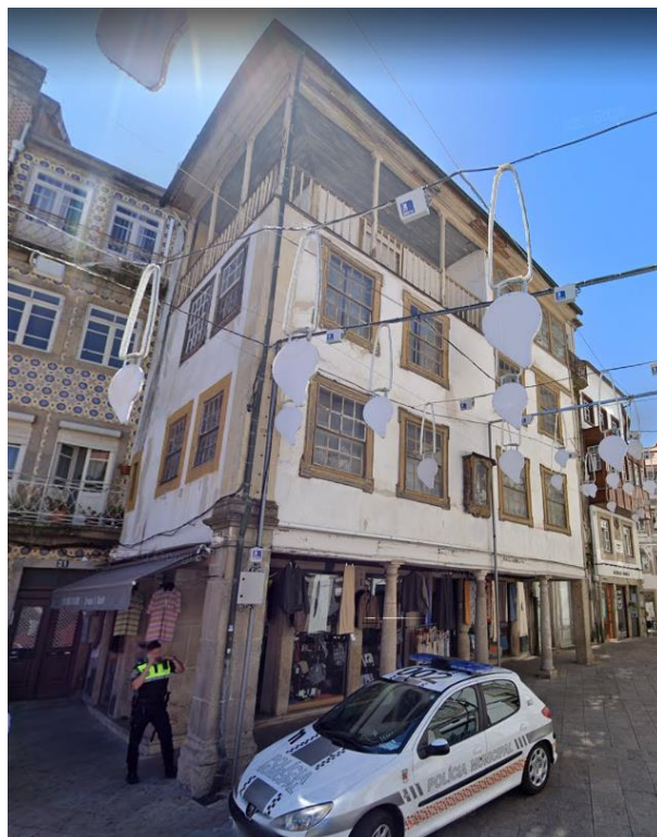
Figura 8 - Fachada Casa dos Balcões.
