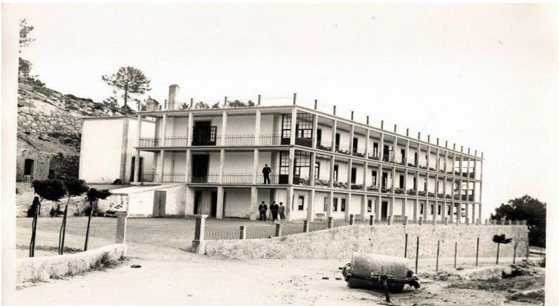
Figura 18 - Sanatório Santa Maria na fase final de construção (1930)
