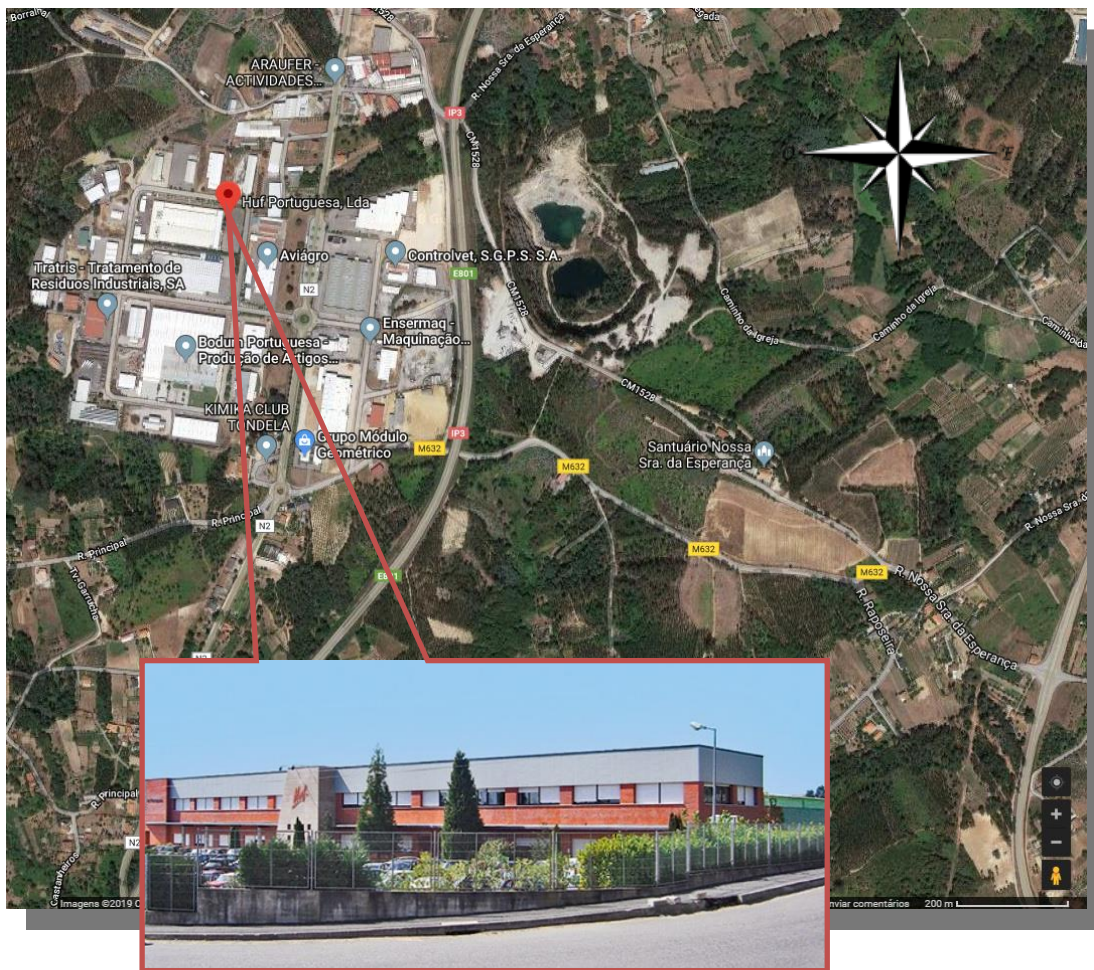
Figura 7-1 – Fotografia aérea e ao nível do solo (Google Maps, 2019)
