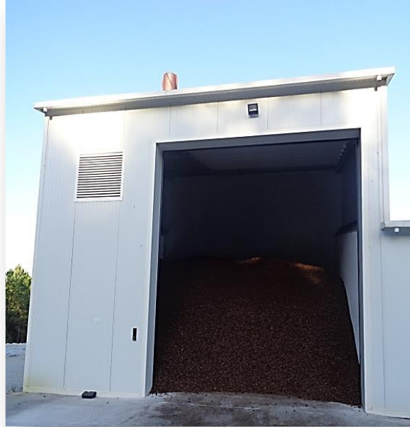
Figura 45: Anexo destinado à arrumação de produtos de queima.
