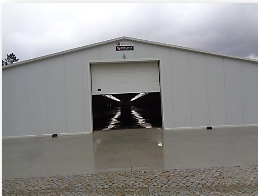
Figura 59: Exterior do pavilhão avícola, após a respetiva lavagem.
