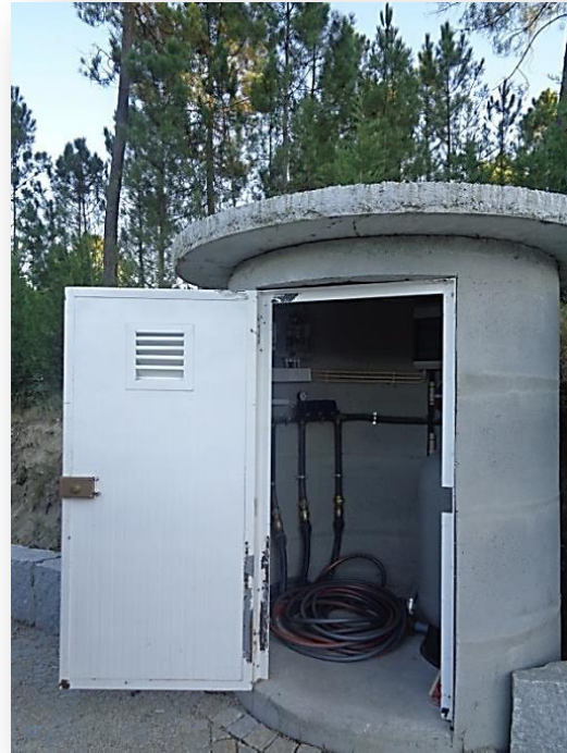
Figura 46: Furo cartesiano (esquerda) e respetiva cabine de controlo (direita).
