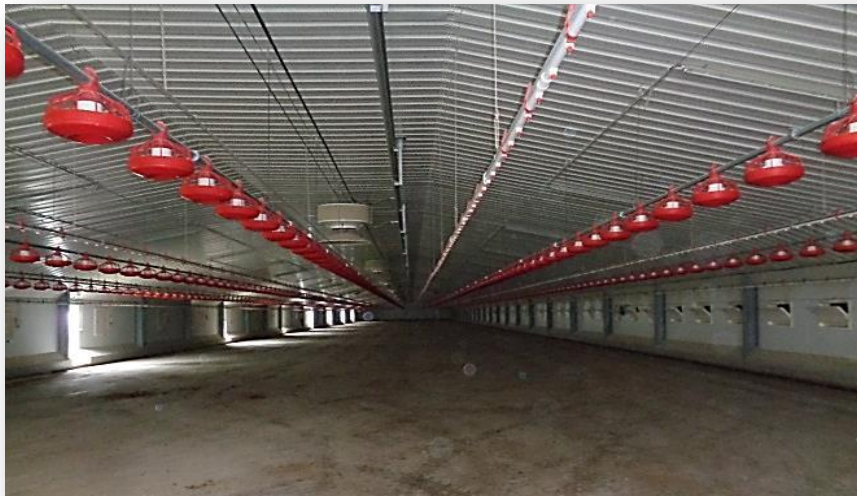
Figura 57: Alojamento das aves após a retirada do estrume.
