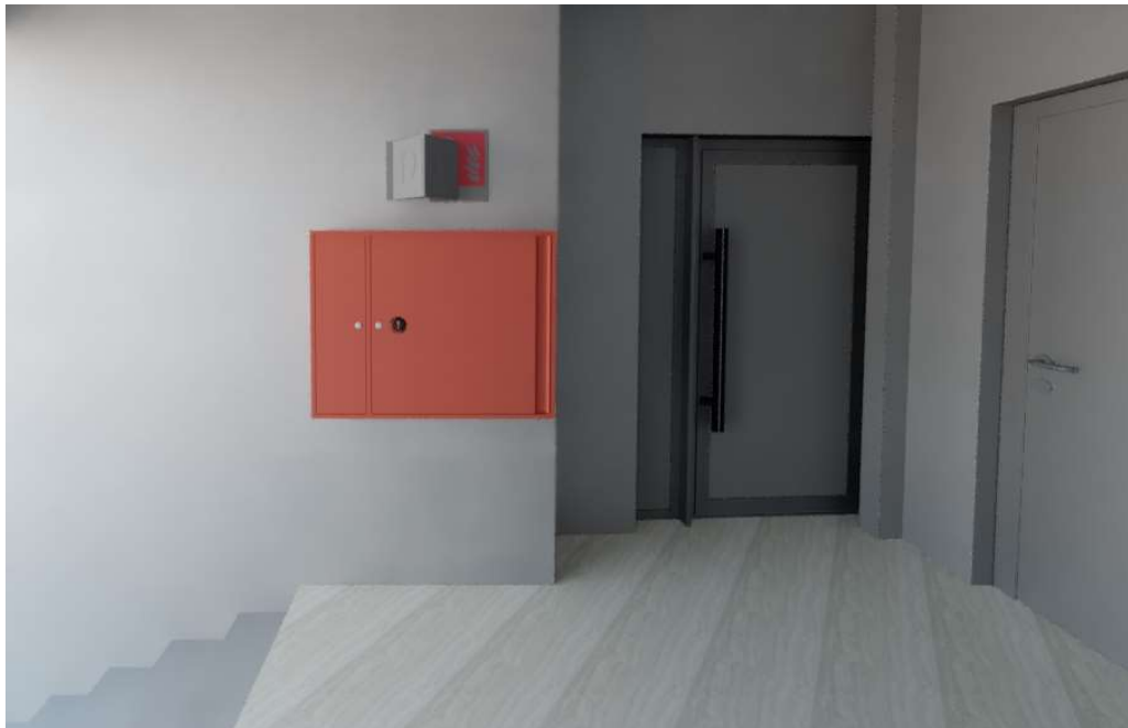
Figura 61 - Carretel zona comercial
