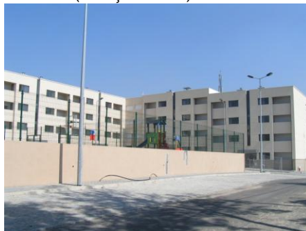
Figura 1 - Vista parcial do empreendimento selecionado.
