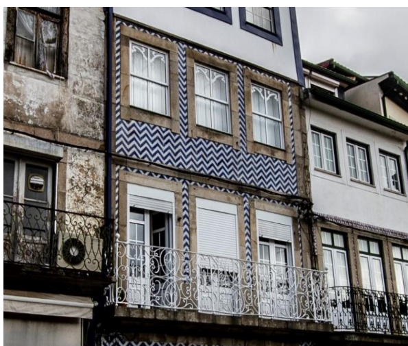
Foto 16 – Edifício, Rua de Almacave, nº 35
