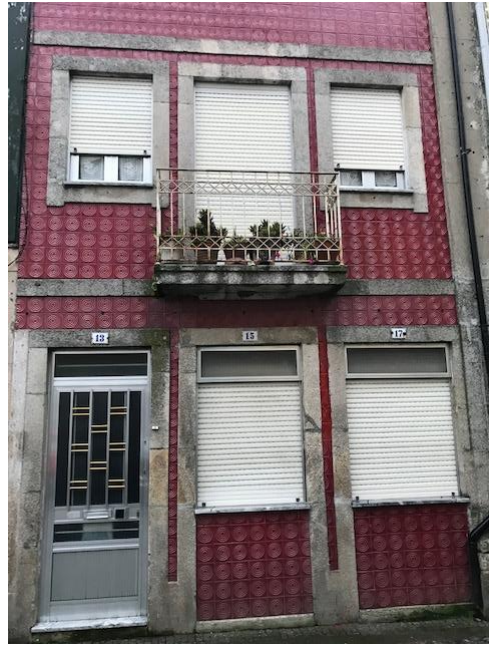
Foto 5 - Edifício, Rua da Cadeia, nº 13-15-17
