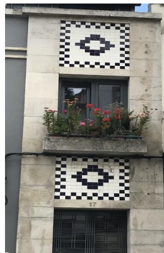
Foto 17 – Edifício, Rua de Almacave, nº 17
