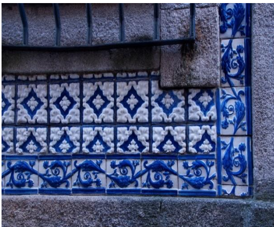
Foto 2 - Edifício, Rua da Cruz, nº 42 (pormenor)
