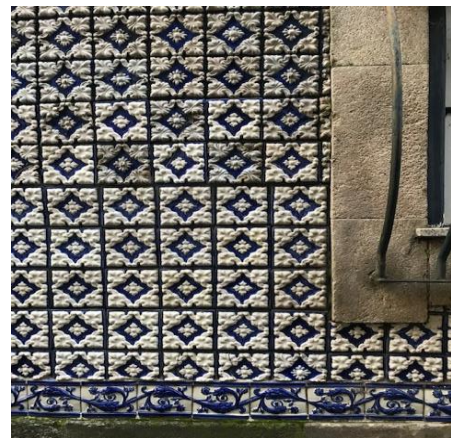
Foto 3 - Edifício, Rua da Cruz, nº 42 (pormenor)
