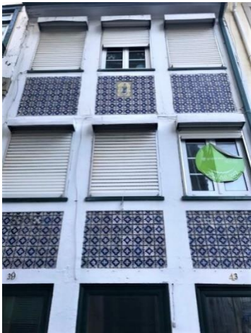
Foto 6 – Edifício, Rua da Cadeia, nº 43
