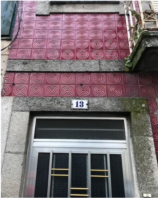
Foto 4 – Edifício, Rua da Cadeia, nº 13
