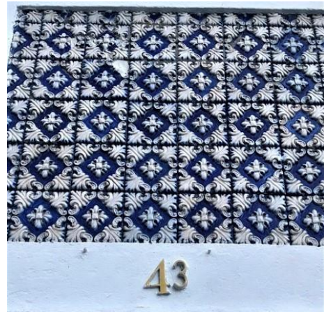
Foto 7 - Edifício, Rua da Cadeia, nº 43 (pormenor)
