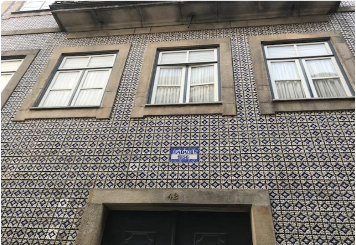
Foto 1 – Edifício, Rua da Cruz, nº 42
