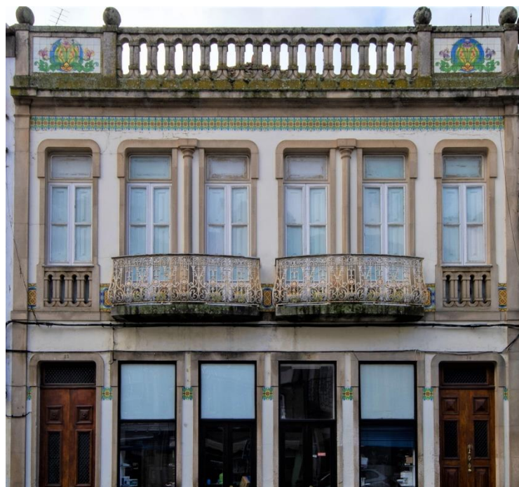
Foto 15 – Edifício, Rua de Almacave, nº 29-33-35
