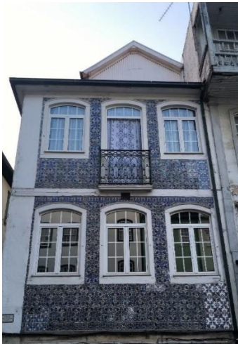
Foto 10 – Edifício, Rua Praça do Comércio, nº 43
