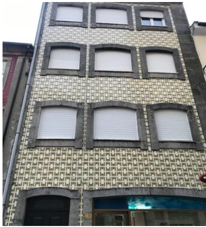
Foto 8 – Edifício, Rua da Cadeia, nº 19
