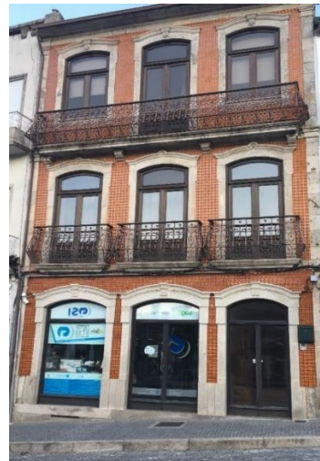
Foto 11 – Edifício, Rua de Almacave, nº 196
