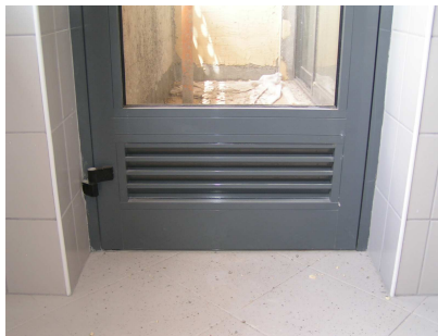
c) Grelha instalada na porta exterior da cozinha.
