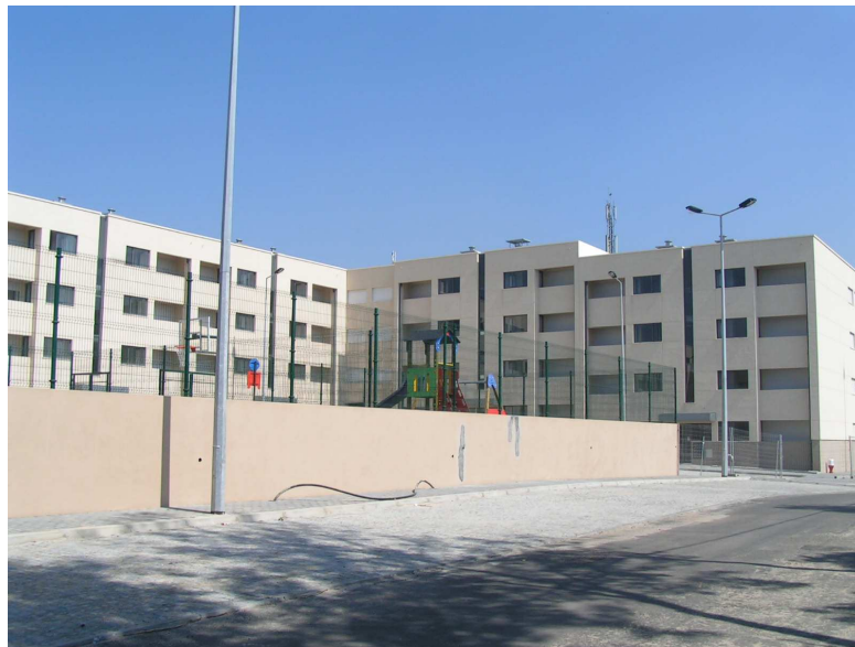
Figura 6.1 - Vista parcial do empreendimento seleccionado.
