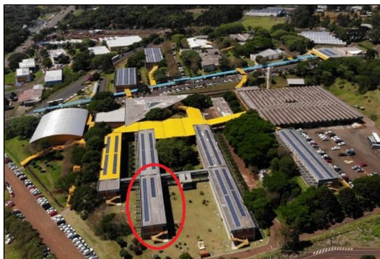
Figura 3-2: Localização do edifício em estudo (bloco M), adaptado de [53]
