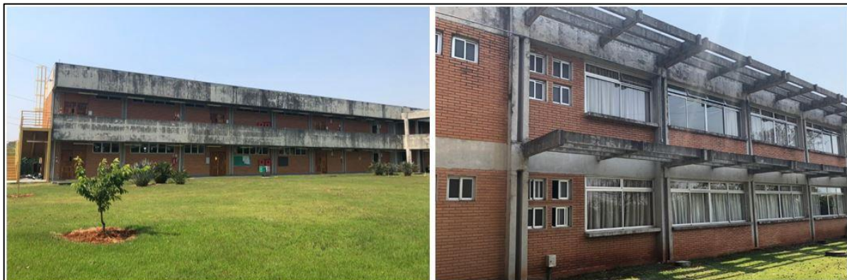
Figura 3-3: Vista frontal (esquerda) e vista posterior (direita) do bloco M
