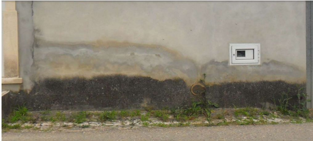
Figura 7 - Humidade ascensional
