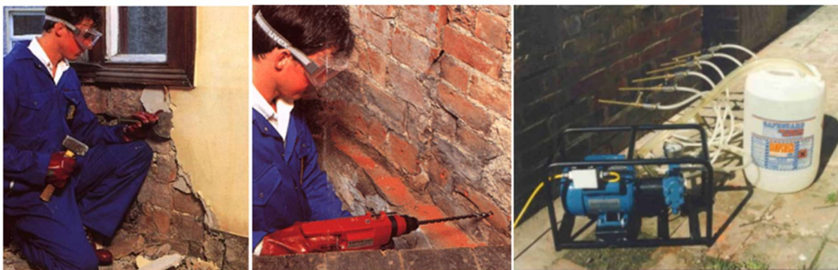
Figura 49 - Processo de introdução em obra do impermeabilizante sob pressão
