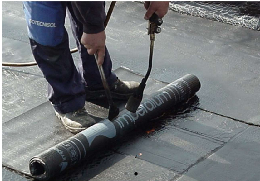
Figura 28 – Demonstração de aplicação de membrana de impermeabilização
