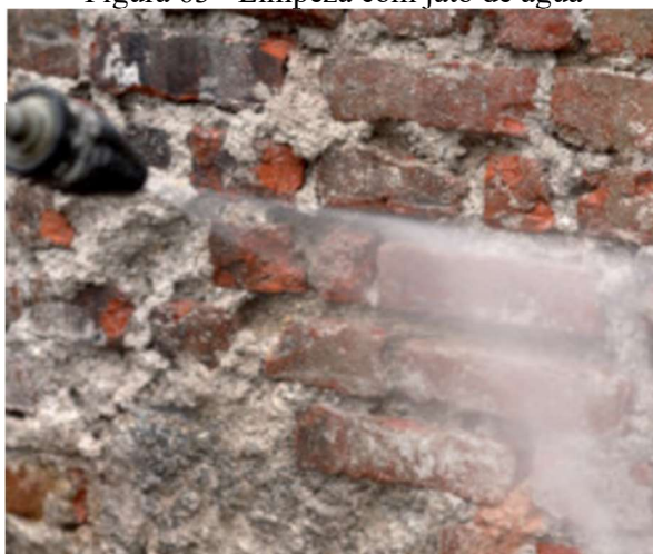
Figura 63 - Limpeza com jato de água
