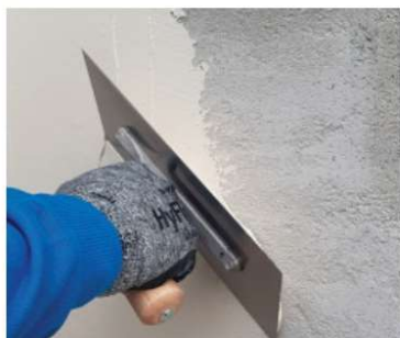
Aplicação de PoroMap Finitura Civile sobre reboco curado
