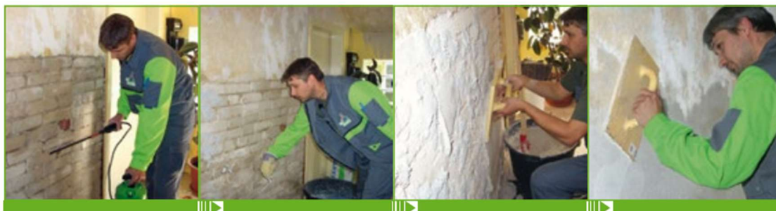
Figura 47 - Revestimentos após a aplicação do produto impermeabilizante
