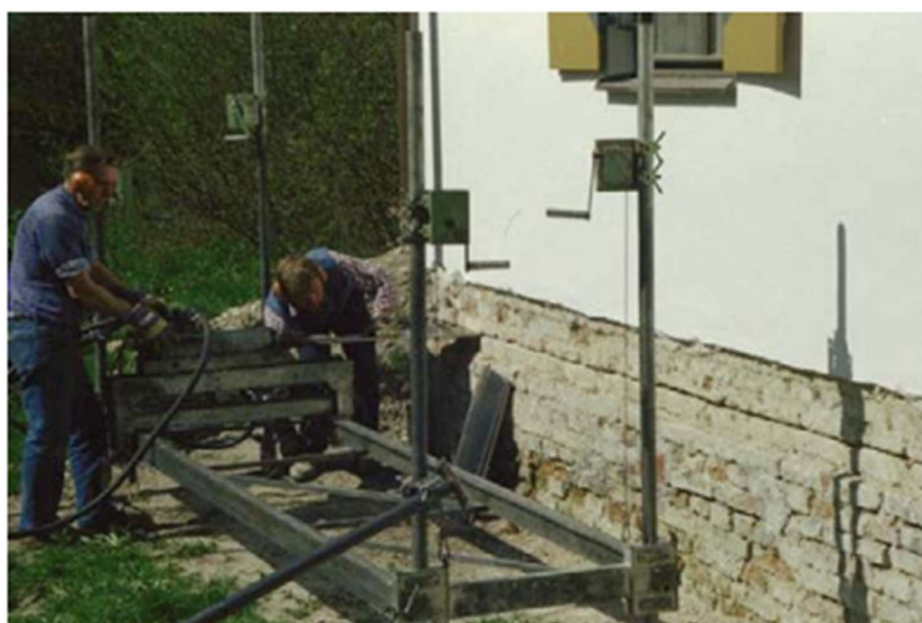
Figura 38 - Corte com Serra Diamantada
