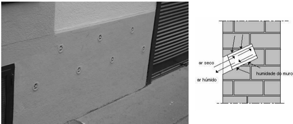
Figura 54 - Tubos de arejamento
