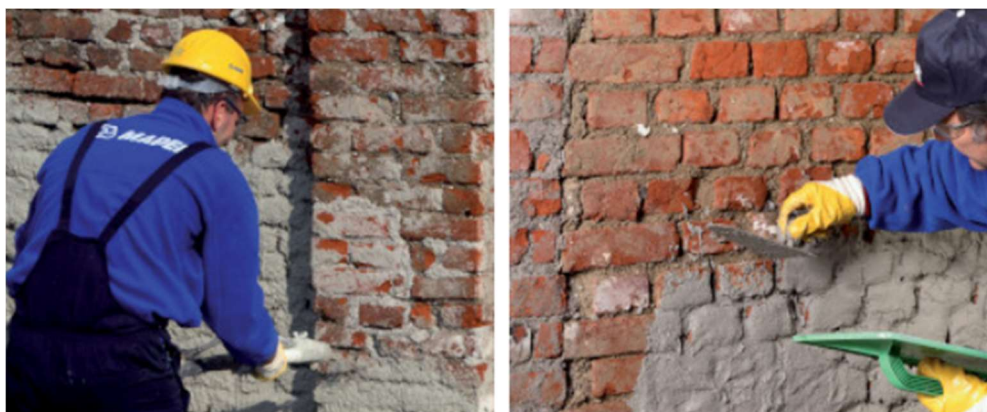
Figura 64 - Aplicação do revestimento, à esquerda com máquina de rebocar e à direita com colher de pedreiro
