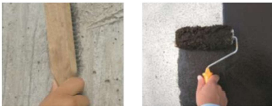
Figura 26 - Preparação do suporte e aplicação da emulsão betuminosa
