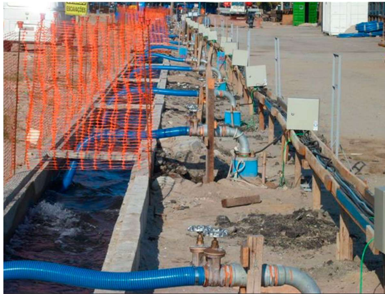
Figura 35 - Rebaixamento do nível freático através de poços de bombagem
