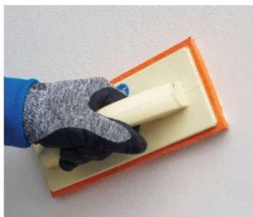
Acabamento com talocha de esponja com PoroMap Finitura Civile
