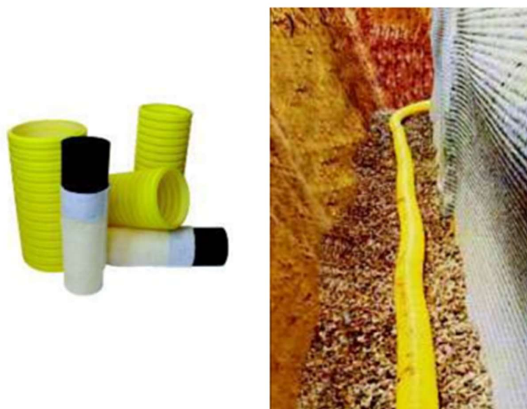
Figura 31 - Tubos de drenagem
