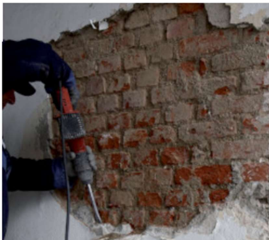
Figura 62 - Demolição do reboco existente
