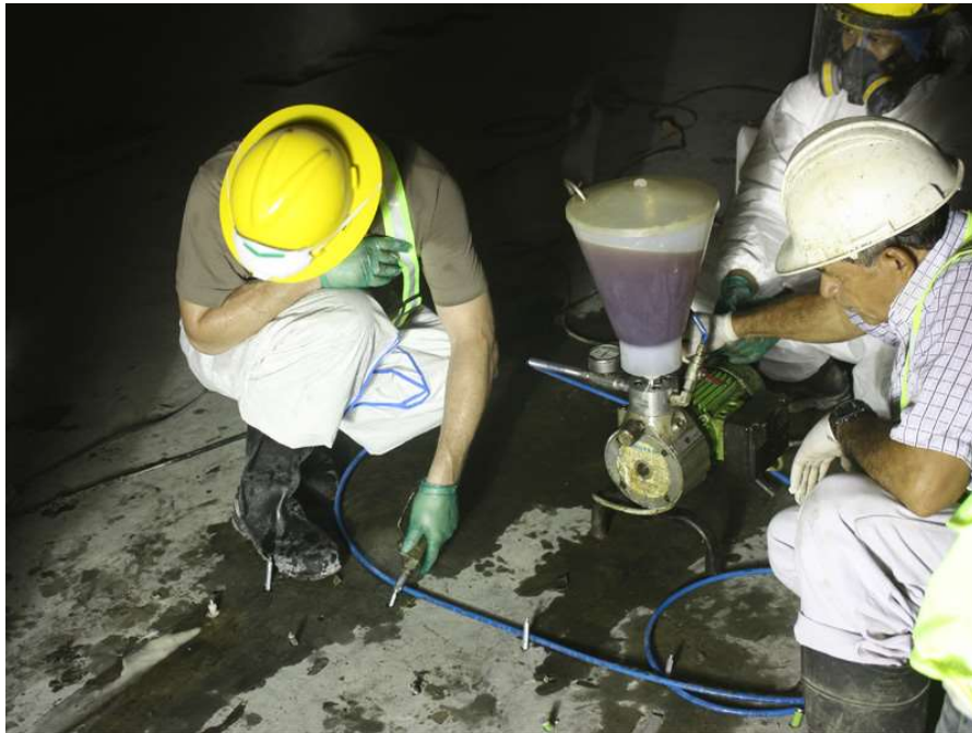
Figura 48- Barreiras horizontais com injeção de pressão
