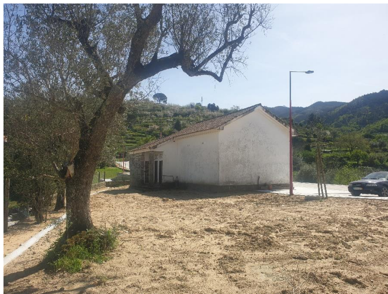
Figura 31 – Vista traseira da antiga escola de Caldas de Arêgos, onde será construído o miradouro com parque de merendas
