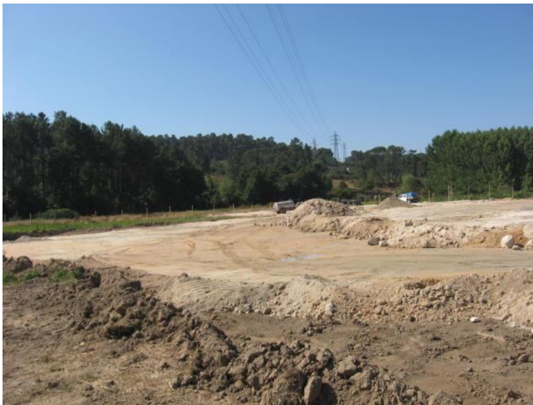
Fig. 6 – Movimentação de terras – colocação e compactação de saibro para 2ª camada do aterro.
