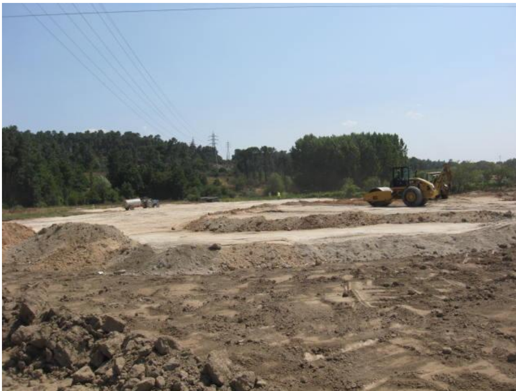
Fig. 2 – Movimentação de terras – compactação de plataforma com saibro.
