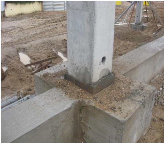
g) Selagem com sikagrout
