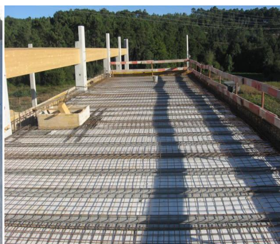
d) Armadura de ferro da laje
