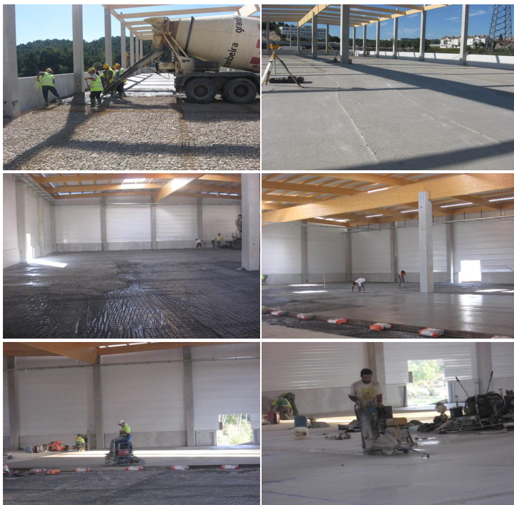
Figura 4-9: Execução do piso térreo
