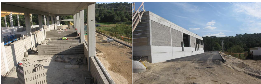
Figura 4-16: Paredes de bloco de cimento
