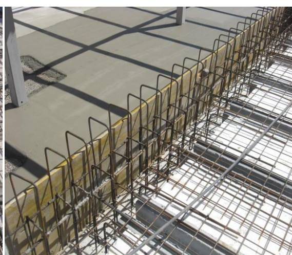
f) Armadura de ferro da viga lateral – V1
