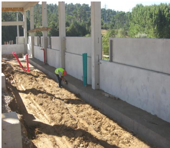
d) Sapata em betão armado
