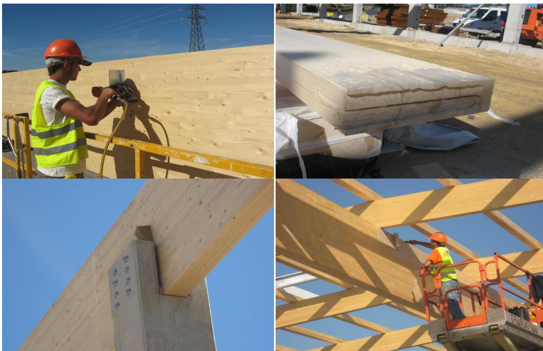
Figura 4-15: Aplicação de chapas metálicas, encaixes nas vigas, varões roscados e tratamento da madeira
