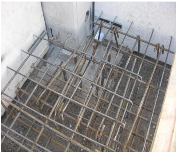
c) Amarração de canto painéis - pilar
