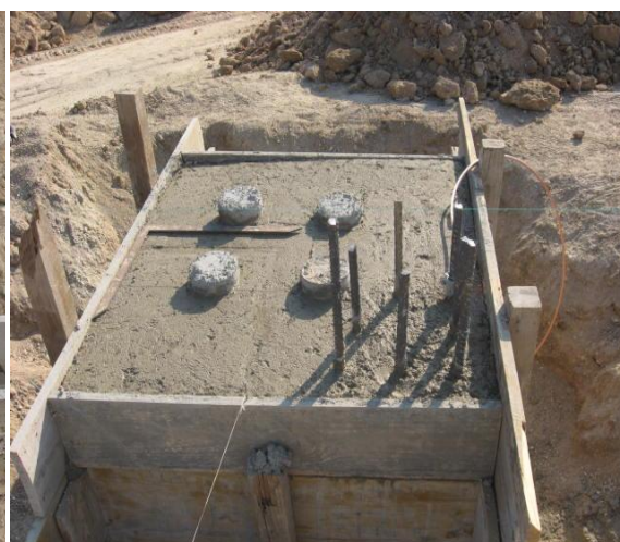
d) Maciço betonado
