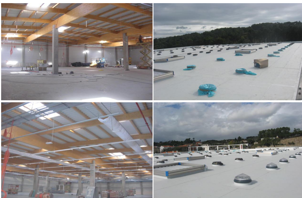
Figura 4-18: Cobertura da zona comercial (interior/exterior)
