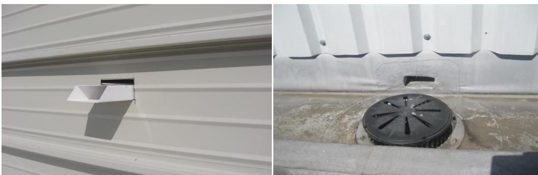
Figura 4-20: Gárgula e dreno de drenagem
