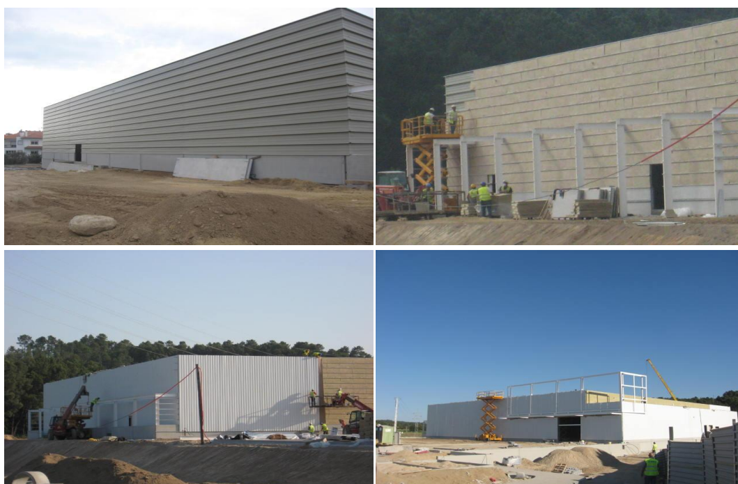
Figura 4-17: Revestimento das paredes exteriores
