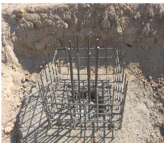
c) Armadura para maciço de encabeçamento
