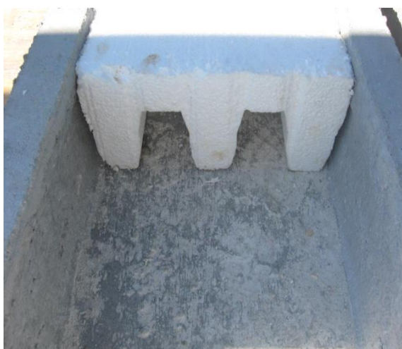
c) Módulos em esferovite (menos 22+4)
