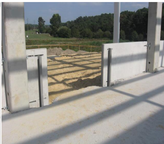
h) Ligação do painel a dois prumos metálicos
