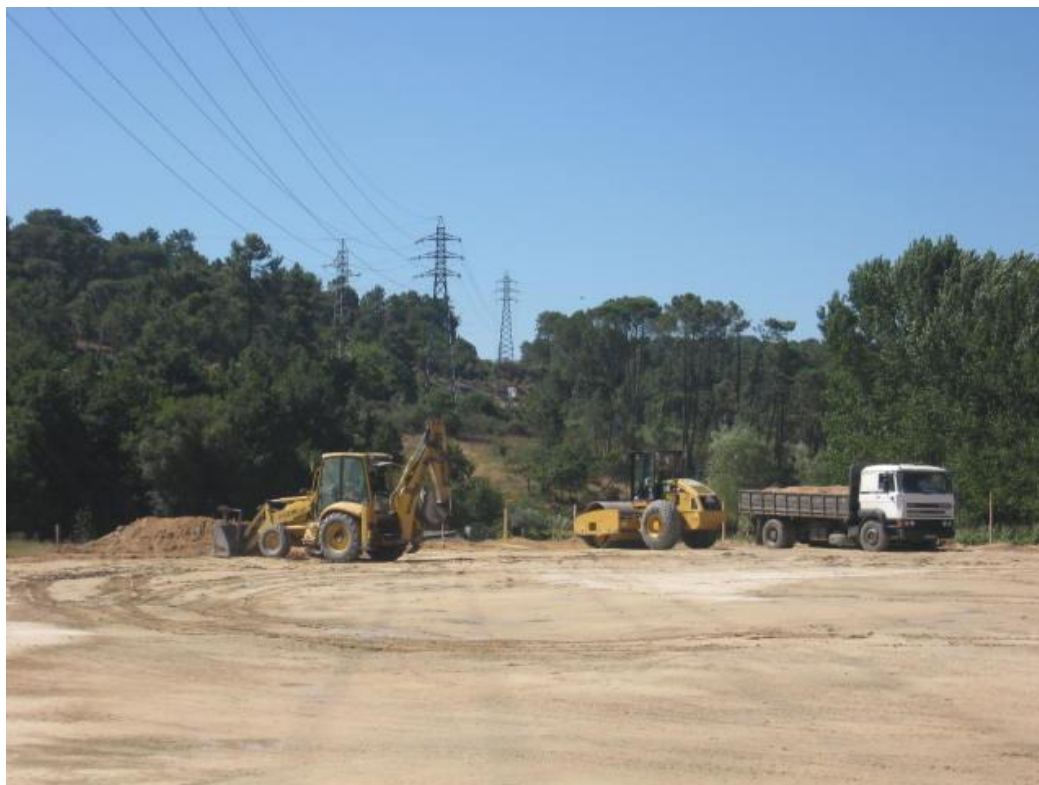
Fig. 7 – Movimentação de terras – colocação e compactação de saibro para 2ª camada do aterro.
