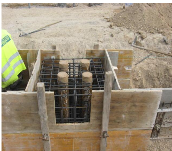
e) Colocação de bainhas metálicas
