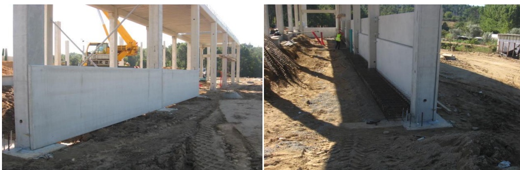
Figura 4-11: Estrutura Pré-fabricada
