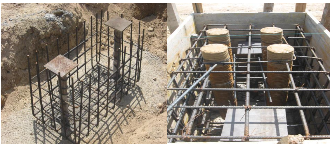
b) Colocação de chapa metálica (reforço/tampa) c) Amarração de bainhas metálicas
