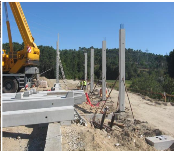
h) Processo aplicação dos pilares
