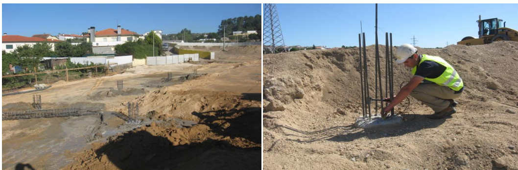
Figura 4-6: Execução de estacas e respetivos ensaios
