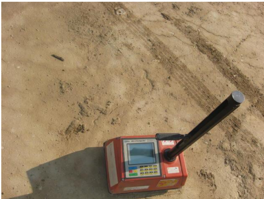
Fig. 10 – Ensaio da 2ª camada do solo do aterro: Gamadensímetro.
