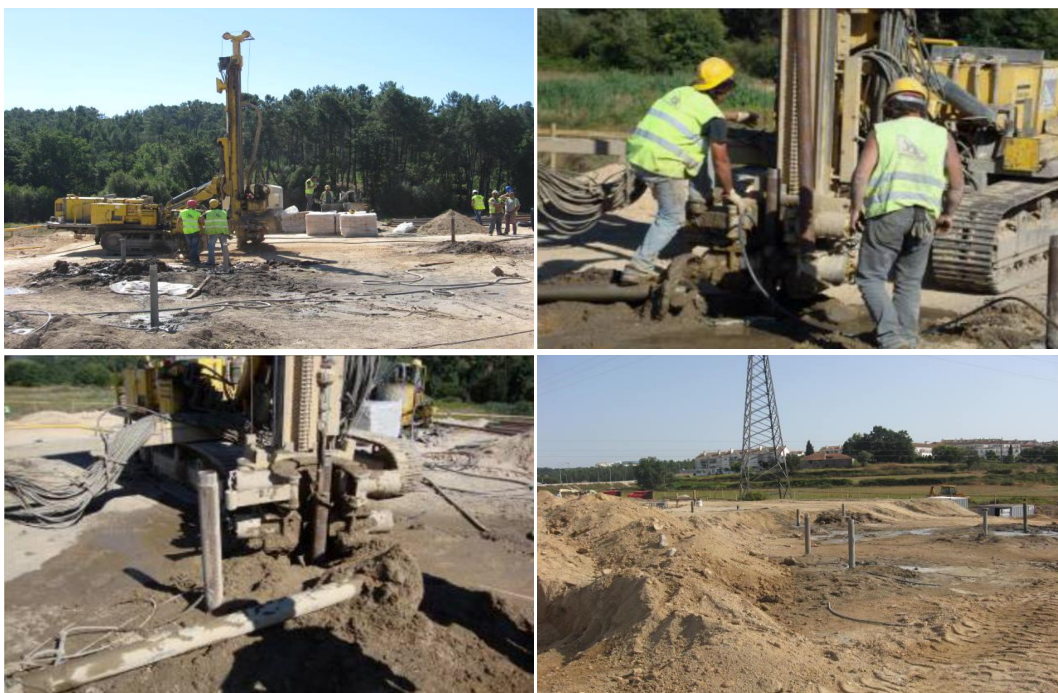
Figura 4-7: Execução de microestacas
