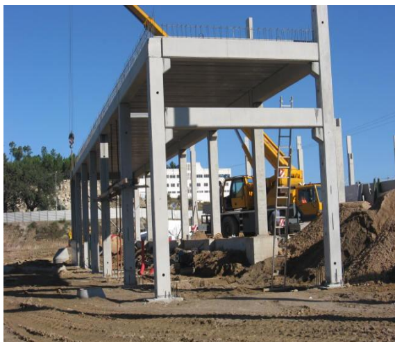
a) Estrutura pré-fabricada da laje menos Castelo b) Lajetas preenchidas módulos em esferovite
