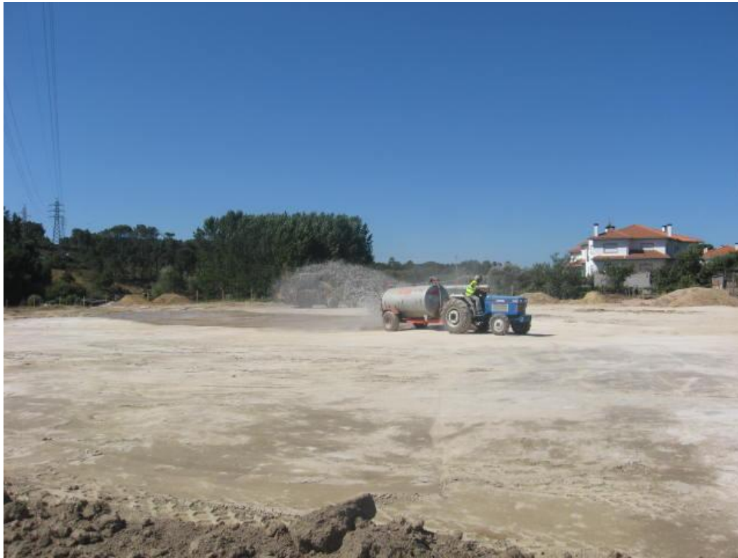
Fig. 5 – Rega com água do aterro.
