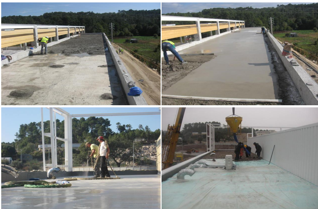
Figura 4-19: Cobertura da zona de serviços e armazém
