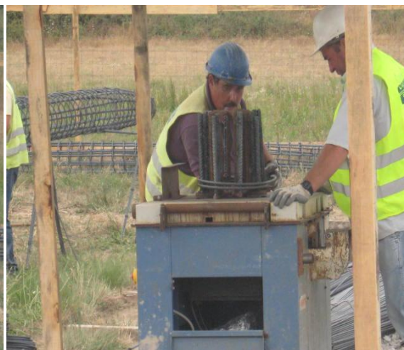
b) Execução de estribos das estacas
