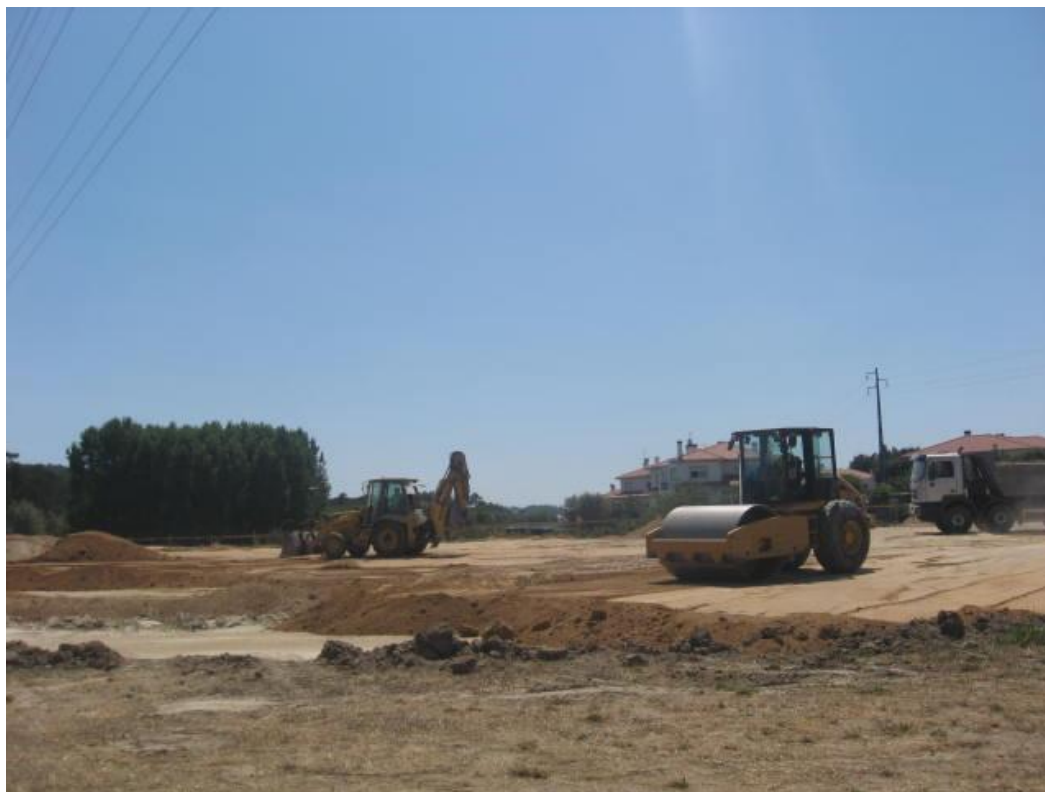
Fig. 15 – Movimentação de terras: colocação e compactação de saibro na 2ª camada (rectificada).
