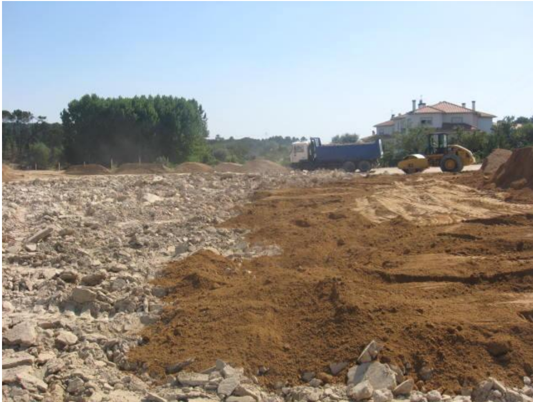
Fig. 13 – Movimentação de terras – rectificação da zona escarificada.
