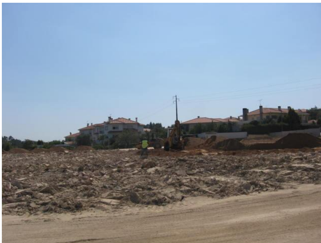
Fig. 12 – Zona do aterro escarificada.
