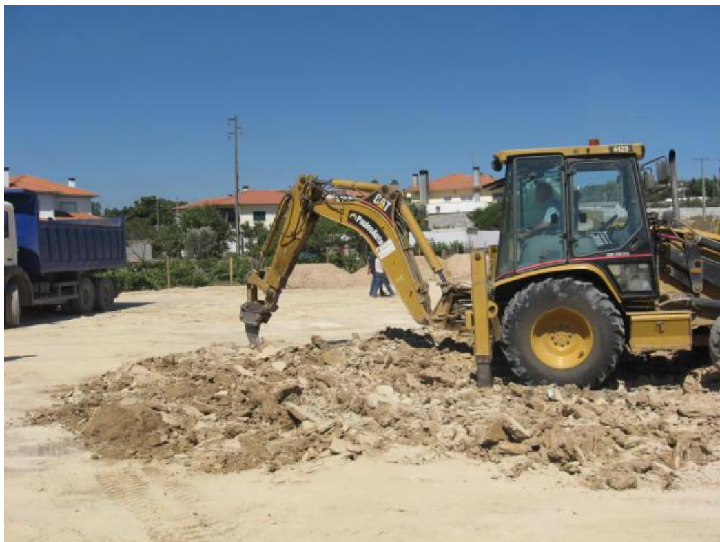
Fig. 11 – Movimentação de terras – escarificação de zona, onde se obtiveram resultados com teor de humidade alto para os que são exigidos.
