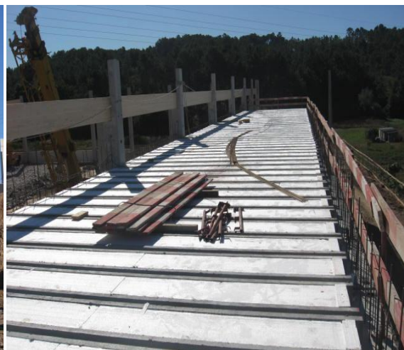
a) Estrutura pré-fabricada da laje menos Castelo b) Lajetas preenchidas módulos em esferovite
