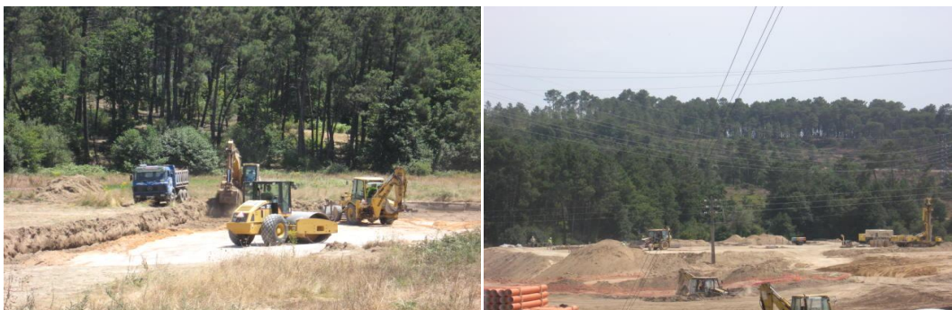
Figura 4-5: Movimentação de terras
