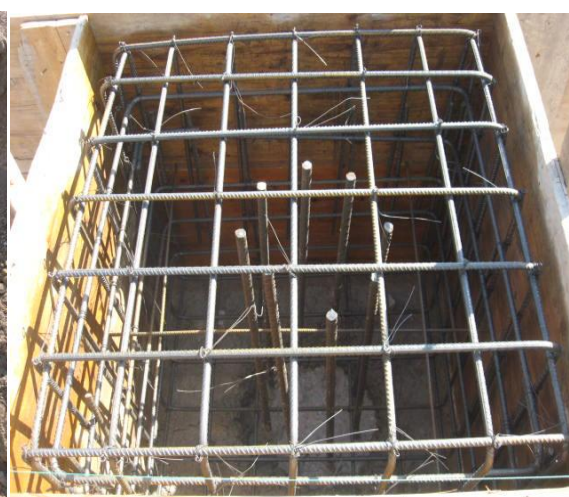
d) Armadura do maciço de encabeçamento
