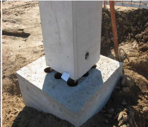
f) Encaixe do pilar no maciço
