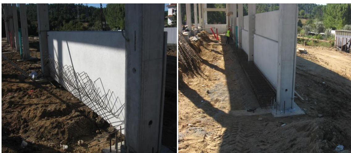
a) Arranques para armadura de sapata
