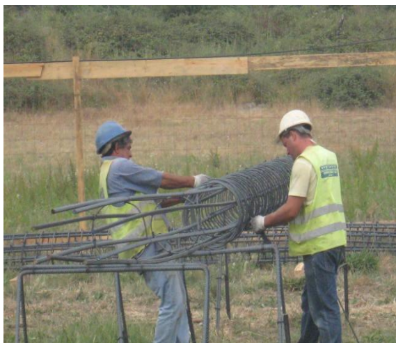
a) Execução de armadura de estacas
