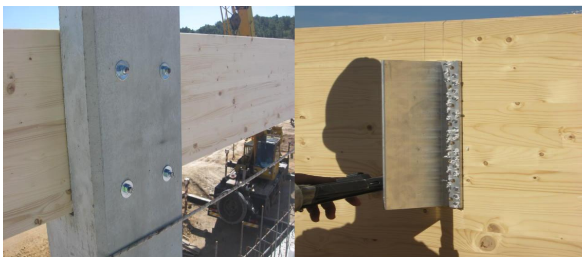
e) Ligação aparafusada entre pilar e viga V4 f) Ligação metálica na viga V4 para viga V3
