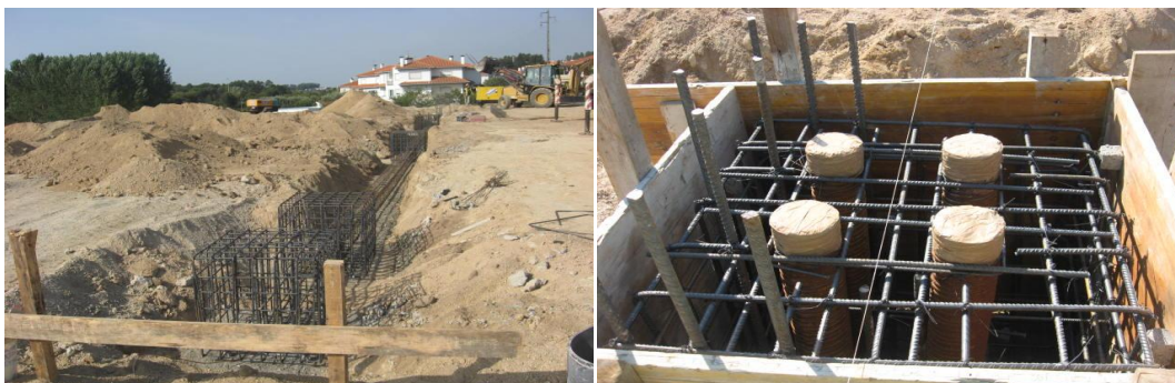
Figura 4-8: Armaduras de vigas de fundação e maciços de encabeçamento
