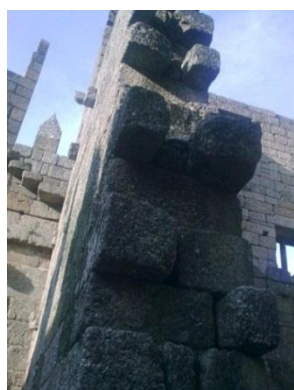
Figura 17 - Parede de alvenaria de pedra de dois paramentos sem ligação (edifício situado em Mangualde)
