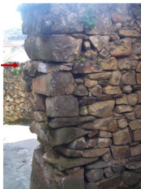
Figura 16 - Paredes de alvenaria de pedra de paramento simples de grande espessura (edifício situado em Lamego)
