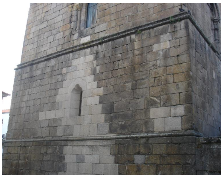
Aspecto de uma estrutura de alvenaria reparada (Sé de Lamego, Viseu)
