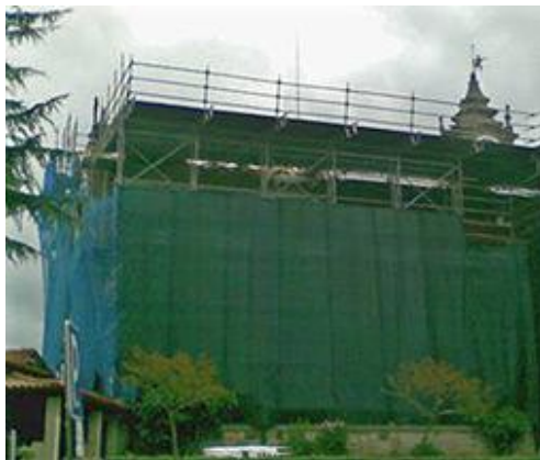
Figura 27 - Cobertura metálica provisória
