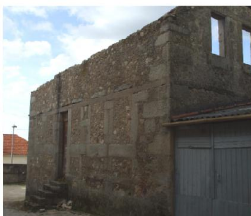
Figura 15 - Edifício em alvenaria e cantaria localizado na vila do Sátão, Viseu
