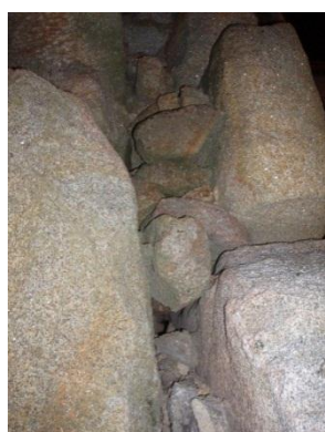
Figura 19 - Parede de alvenaria de pedra de três paramentos (edifício situado em Alijó)
