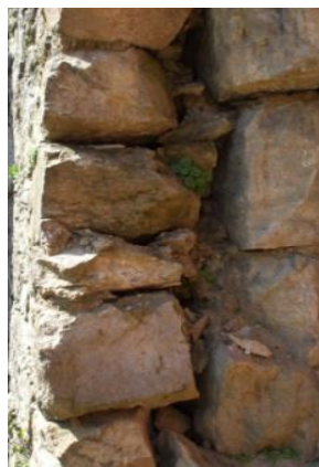
Figura 17 - Parede de alvenaria de pedra de dois paramentos sem ligação (edifício situado em Mangualde)
