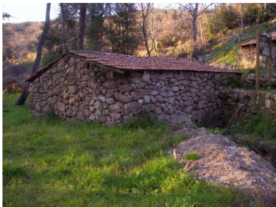
Figura 12 - Moinho de pedras roladas de granito localizado em Alcafache, Viseu
