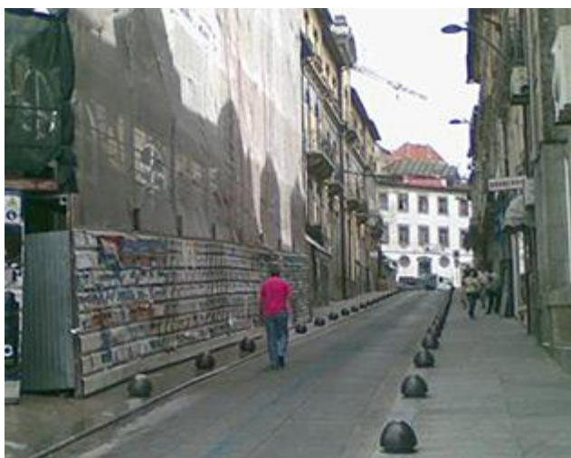
Figura 25 - Conflito via pública vs estaleiro-vedação
