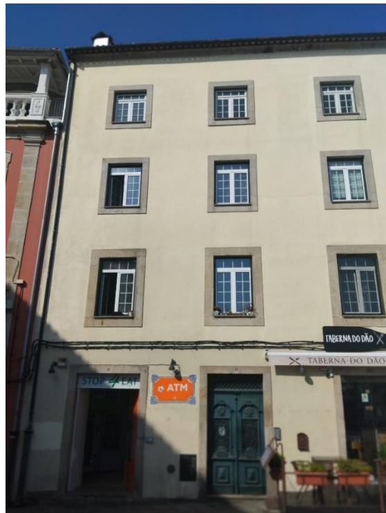
Figura 53AN B: Fachada 11
