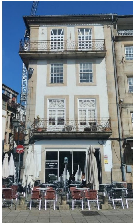
Figura 50AN B: Fachada 8
