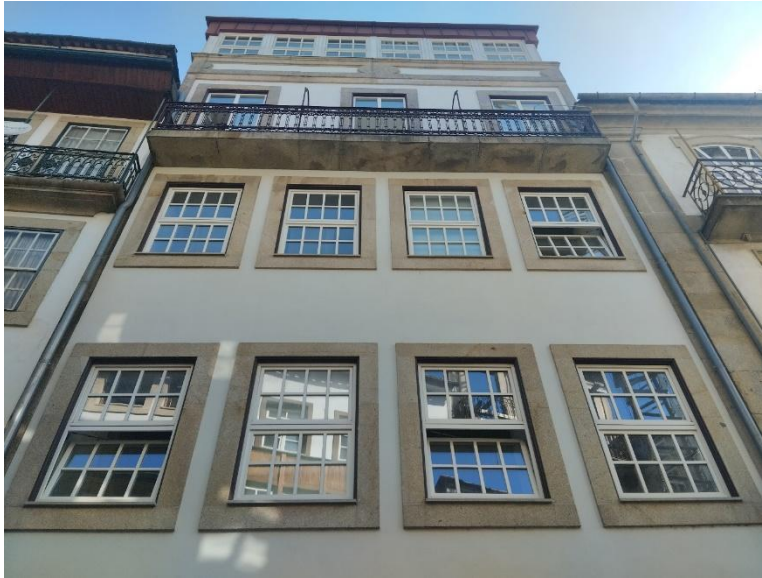
Figura 48 AN B: Fachada 6
