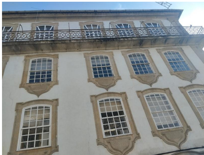
Figura 49 AN B: Fachada 7
