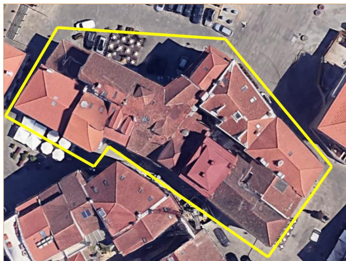
Figura 27: Localização do quarteirão onde foi realizada a inspeção visual das fachadas (Google Earth, 2023)
