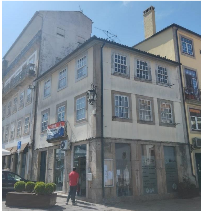
Figura 56AN B: Fachada 16
