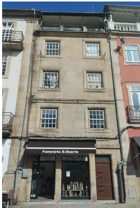
Figura 51AN B: Fachada 9
