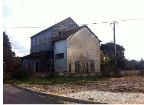
Figura 16, Antigo Posto de Transformação, Site-specific
