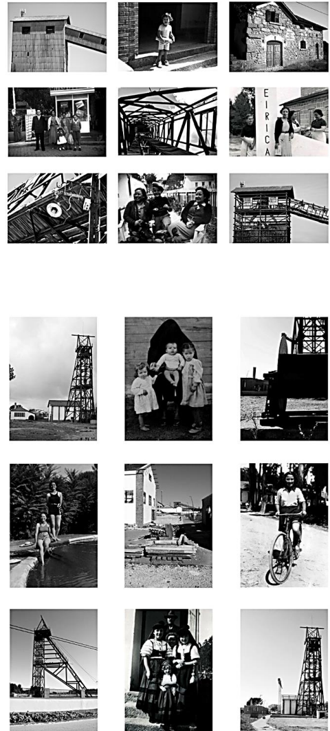
Figura 25, Exemplos de nichos da instalação
