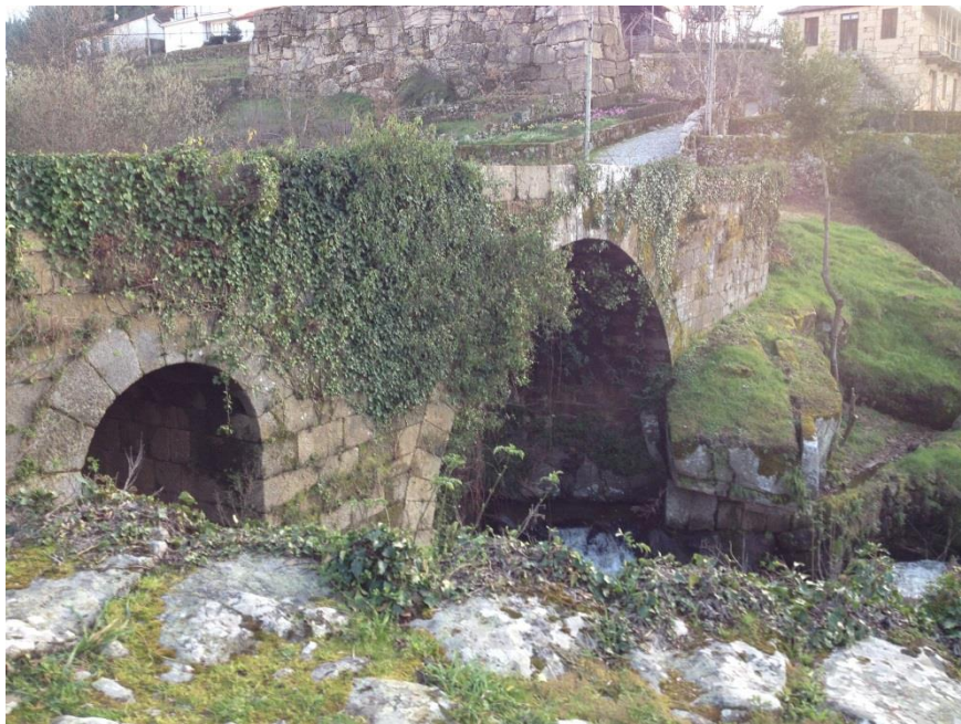
Figura 3-1: Ponte de Salzedas na rua dos moinhos – Tarouca – Portugal
