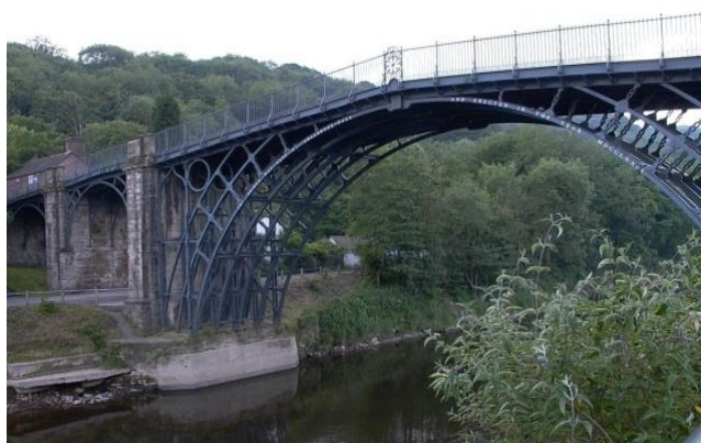
Figura 2-16: Ponte de Coalbrookdale. Extraída de (Wikipedia)
