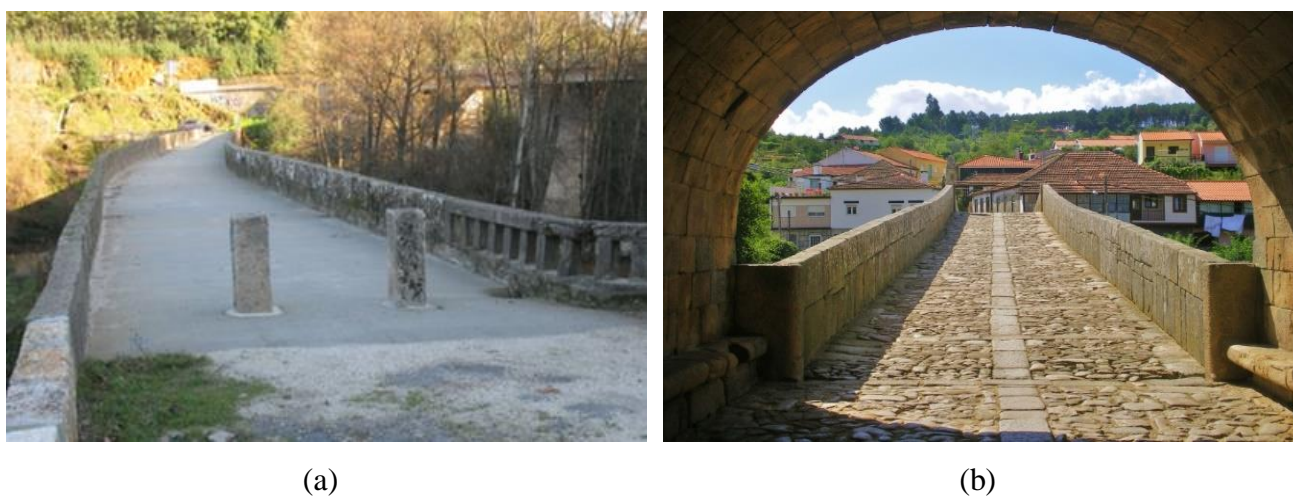
Figura 2-5: Tabuleiro de uma ponte: (a) com material betuminoso; (b) com lajetas de pedra dispostas planamente. Extraídas de (As pontes da minha vida)
