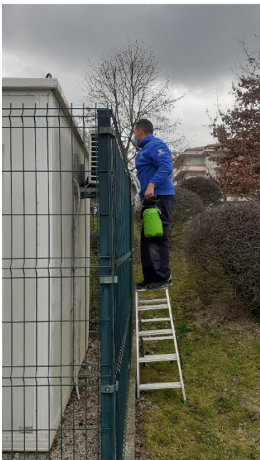
Figura 63 - Manutenção exterior do sistema de ar condicionado
