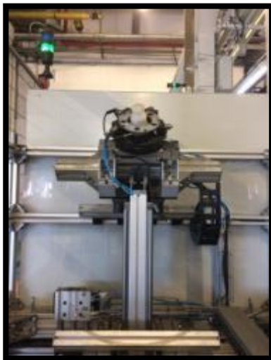
Figura 17 - Evacuador na posição funcional.
