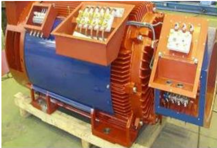
Figura 35- Gerador vista sem estrutura exterior(Gerador, s.d.)
