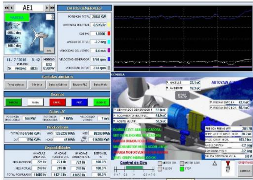
Figura 41- Visualização dos valores de funcionamento do aerogerador (Costa Rica Escuela de Ingeniería Electromecánica, S.d.)
