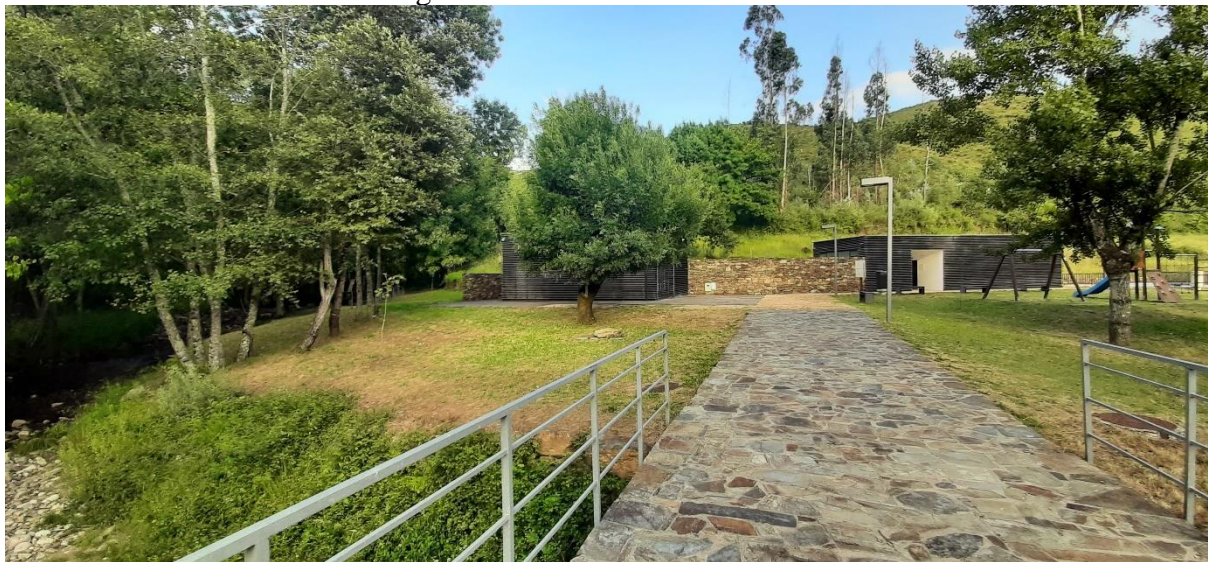
Figura 65 – Ponte e infraestruturas
