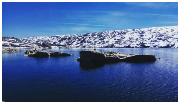
Imagem 201 – Barragem de Lagoa Comprida
