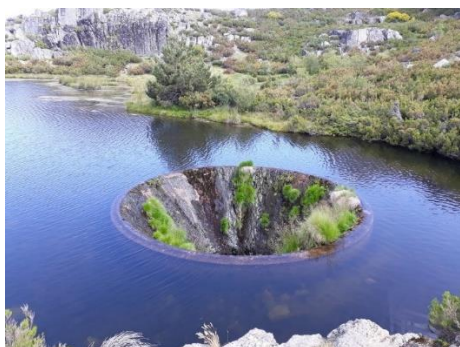
Imagem 200 – Barragem de Lagoa Comprida
