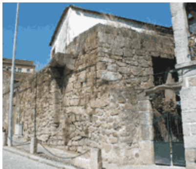
Fig. 2 - Casa Quinhentista da Rua do Chantre - Vista Geral
