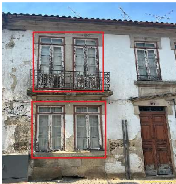
Figura 27 - Janelas da fachada frontal que podem servir como pontos de penetração.
