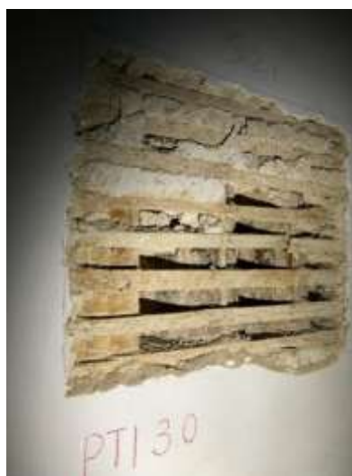
Figura 32 - Alvenaria interna em tabique de madeira.
