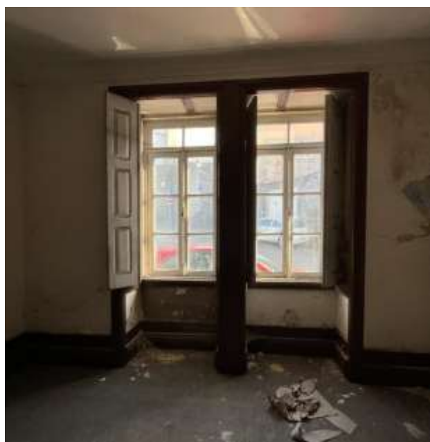
Figura 39 - Parede exterior analisada.
