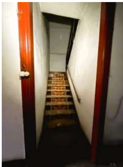
Figura 15 - Escada central que interliga os 3 pisos.
