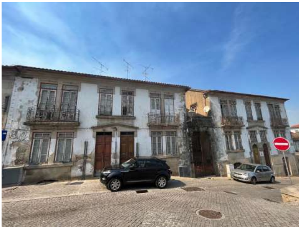
Figura 2 - Vista frontal da edificação estudada.
