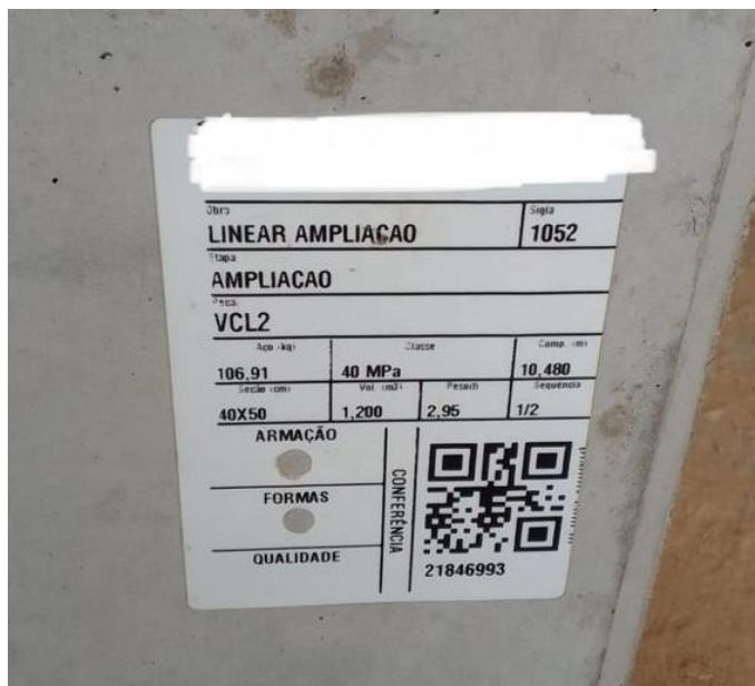
Figura 38: Etiqueta com QR code , impressa e colada em peça pré-fabricada
