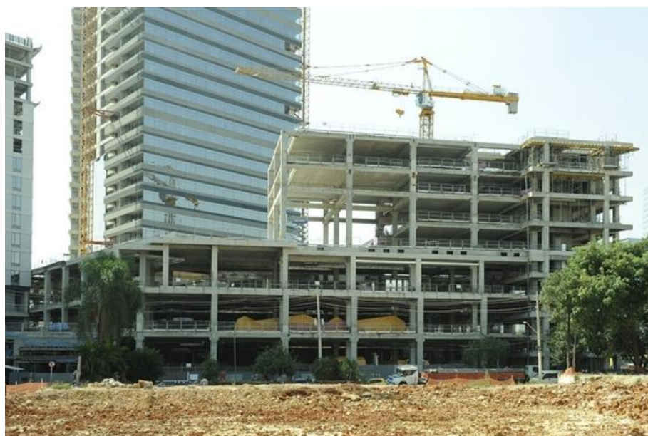
Figura 6: Shopping Parque da Cidade, em construção
