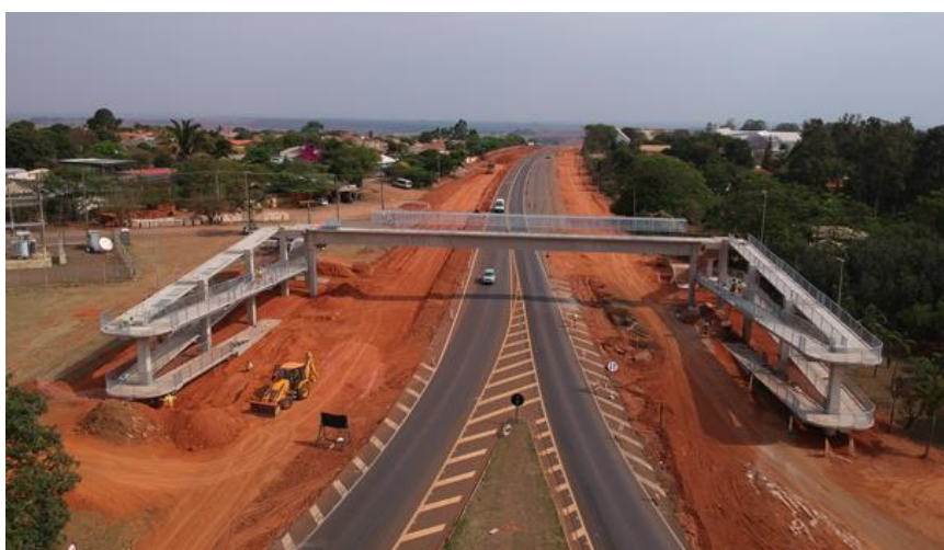
Figura 19: Construção pré-fabricada de passadiço em rodovia de SP
