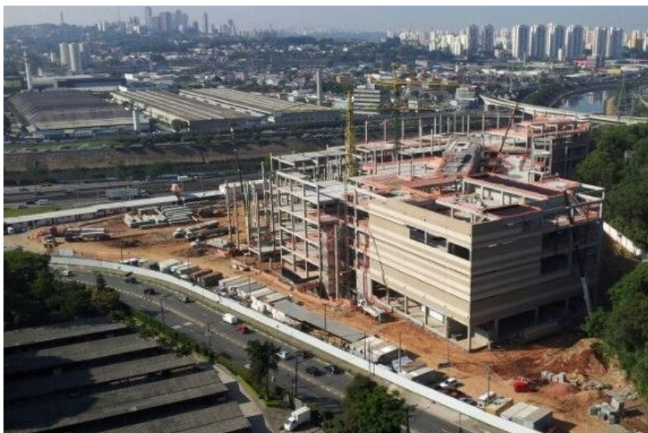
Figura 17: Tietê Plaza Shopping, durante etapa de construção, em sistema reticulado
