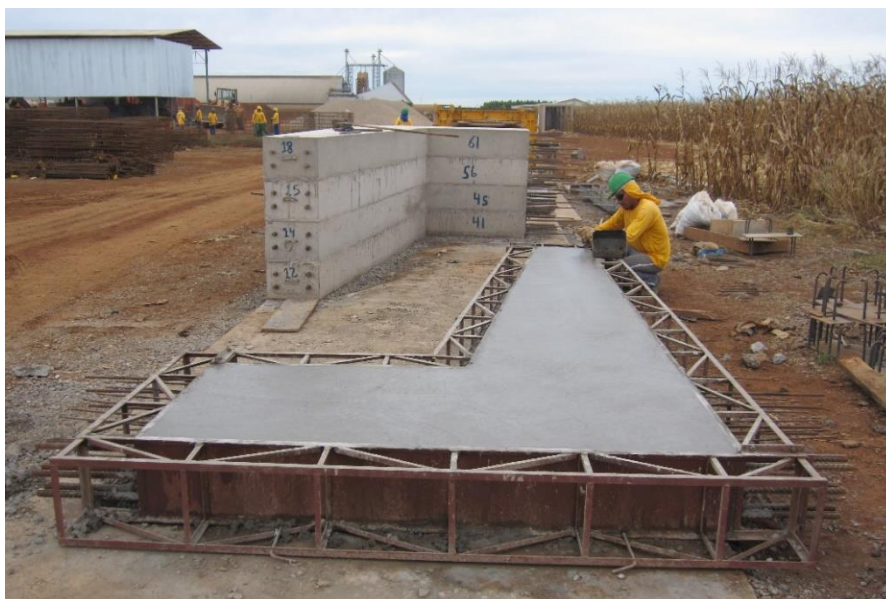
Figura 25: Contraforte pré-moldado in situ
