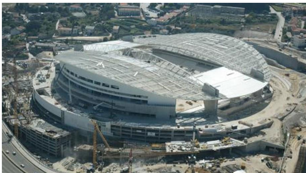
Figura 23: Estádio do Dragão, em construção
