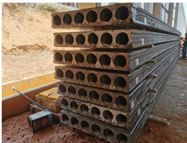
Figura 26: Lajes alveolares pré-esforçadas
