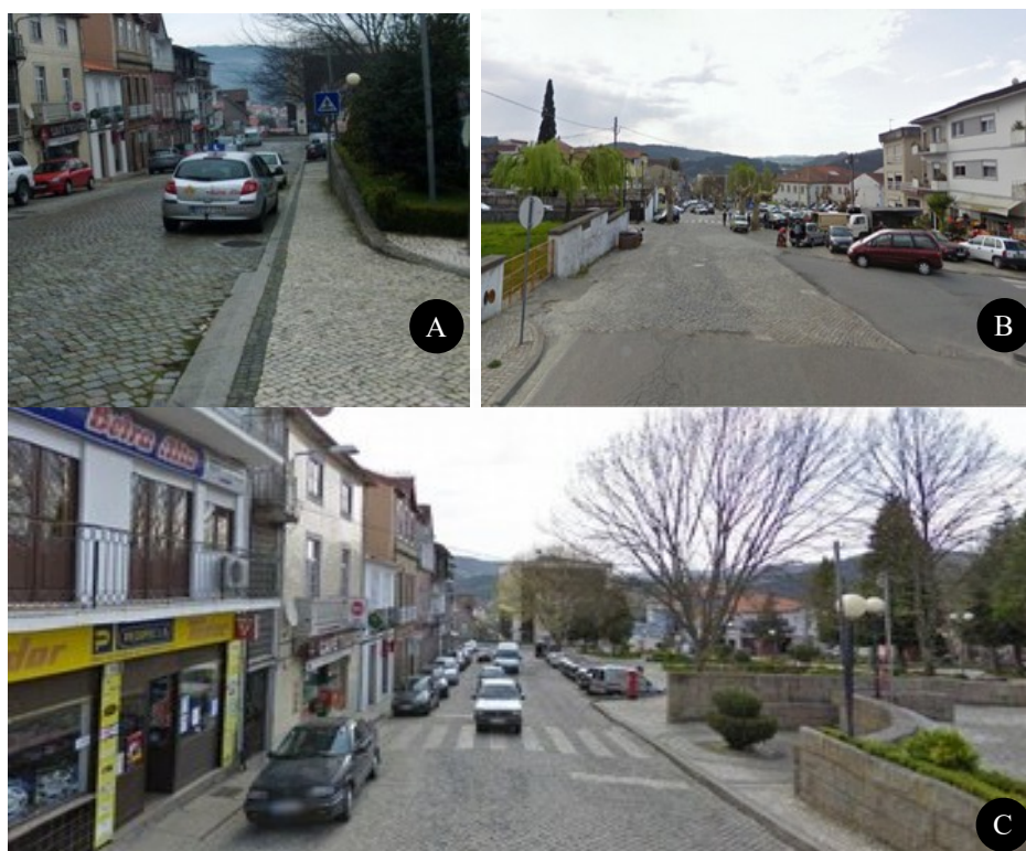
A - Passeios demasiado estreitos, estacionamentos desordenados; B - Diversidade de materiais; C - Falta de lugares de estacionamento.
