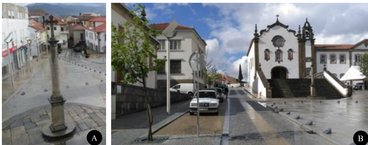
A – Aspeto geral da praça; B – Instalação de delimitadores.
