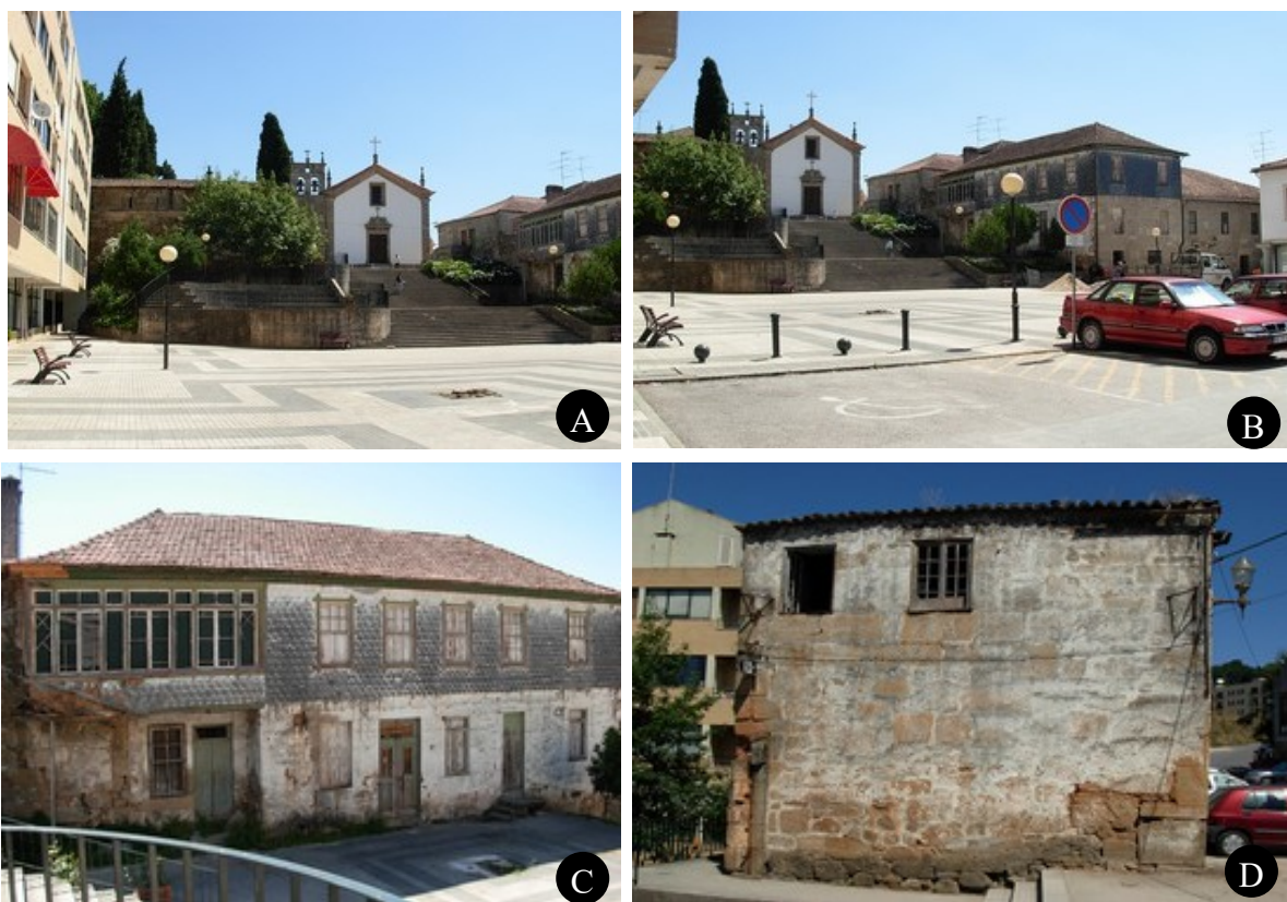
A – Aspeto da praça; B – Outra perspetiva da praça; C – Edifício em mau estado de conservação; D – Edifício em ruína.
