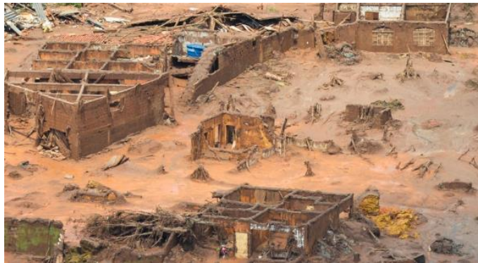
Figura 2-11: Rutura da barragem de Samarco retirada de ( https://brasil.mongabay.com/2018/03/rompimento-da-barragem-rejeitos-mineracao-principal-causa-desastres-ambientais-relatorio/ )
