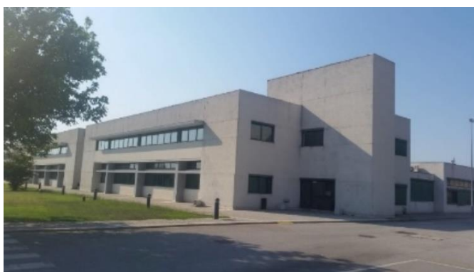
Figura 4-6 Fachadas Sul e Este do bloco de aulas
