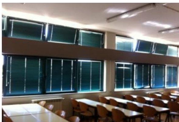
Figura 4-14 Proteção interior dos vãos envidraçados
