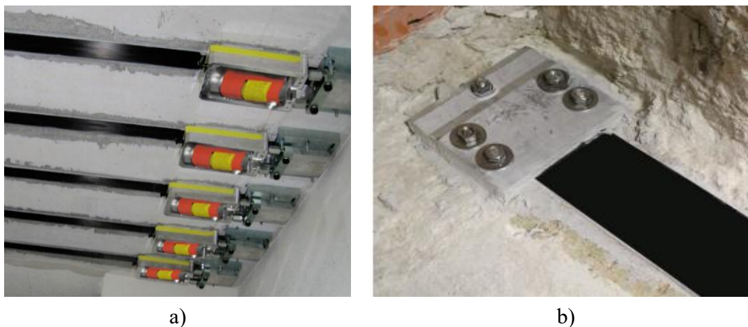
Figura 2.5 - Técnica de reforço EBR: a) com pré-esforço e b) com sistema de ancoragem externo (S&P Clever Reinforcement, 2025)
