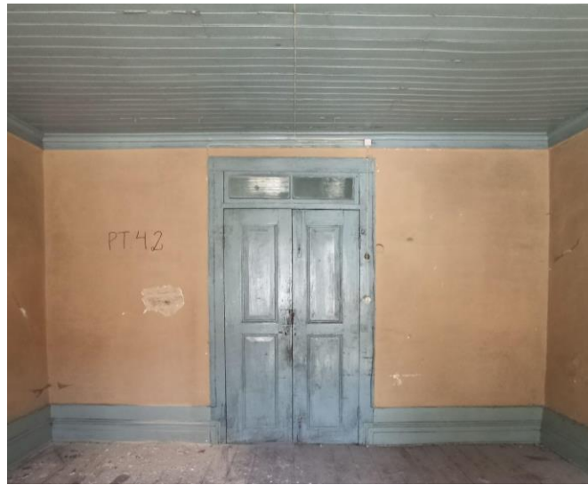
Figura 57: Revestimento do teto em madeira
