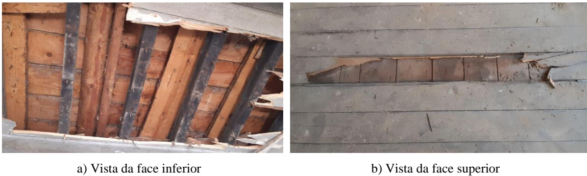
Figura 50: Representação do pavimento do piso 2
