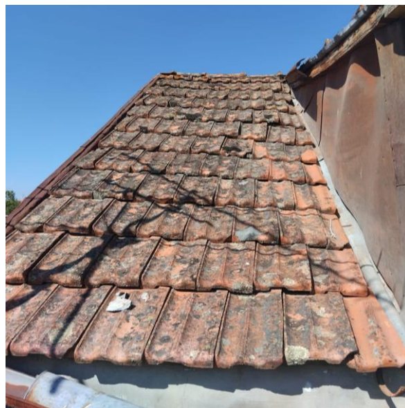
Figura 58: Revestimento da cobertura
