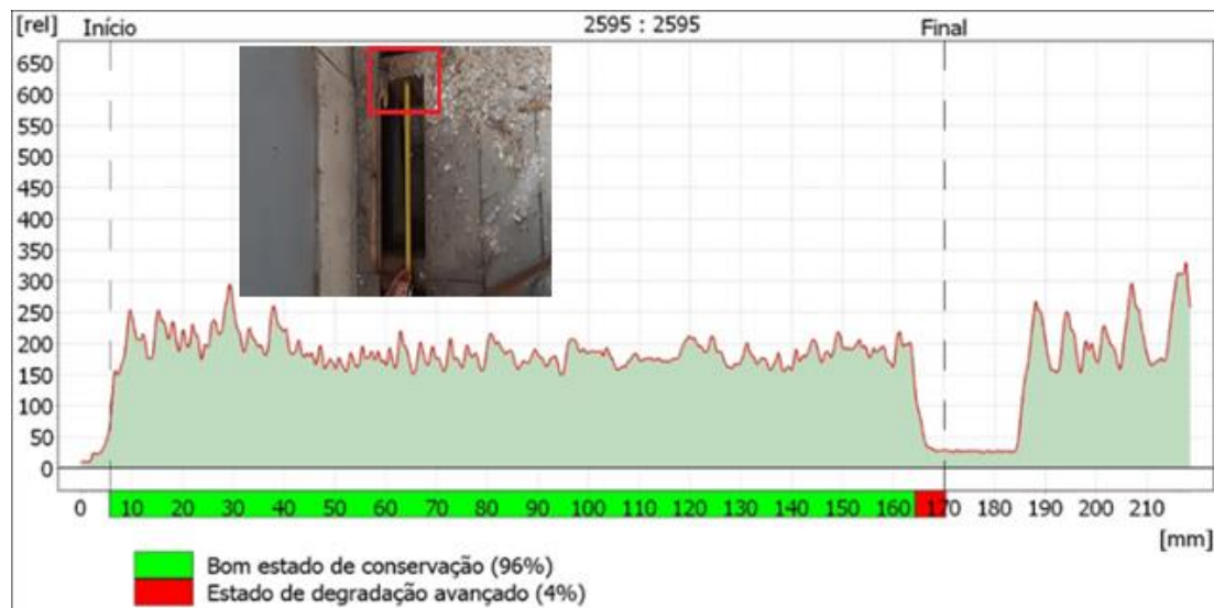
Figura 94: Pav.3 – R.PAV.2.3 (b=7,5cm; h=18cm) – viga do piso 3- Valor médio = 183
