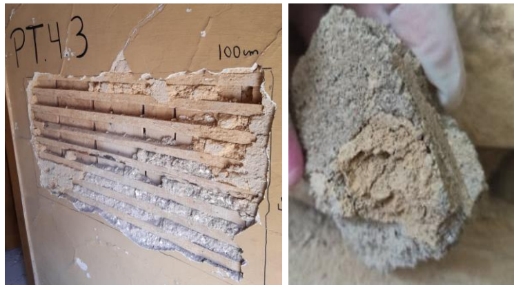
Figura 43: Argamassa de enchimento e preenchimento
