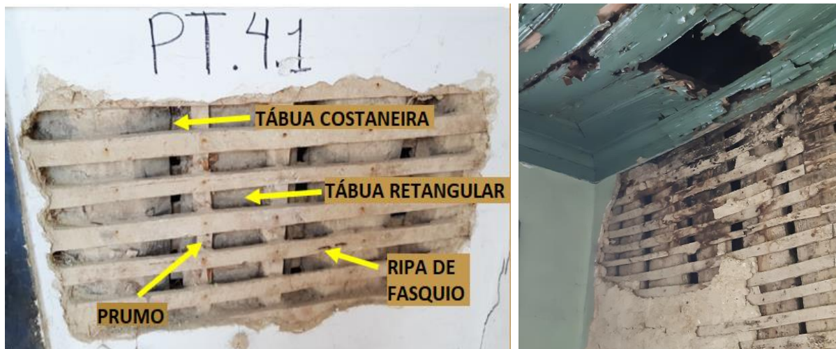
a) Janela de inspeção da parede de tabique PT 4.1
