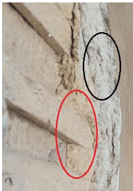
Figura 44: Diferentes argamassas de enchimento e revestimento, com coloração diferenciada
