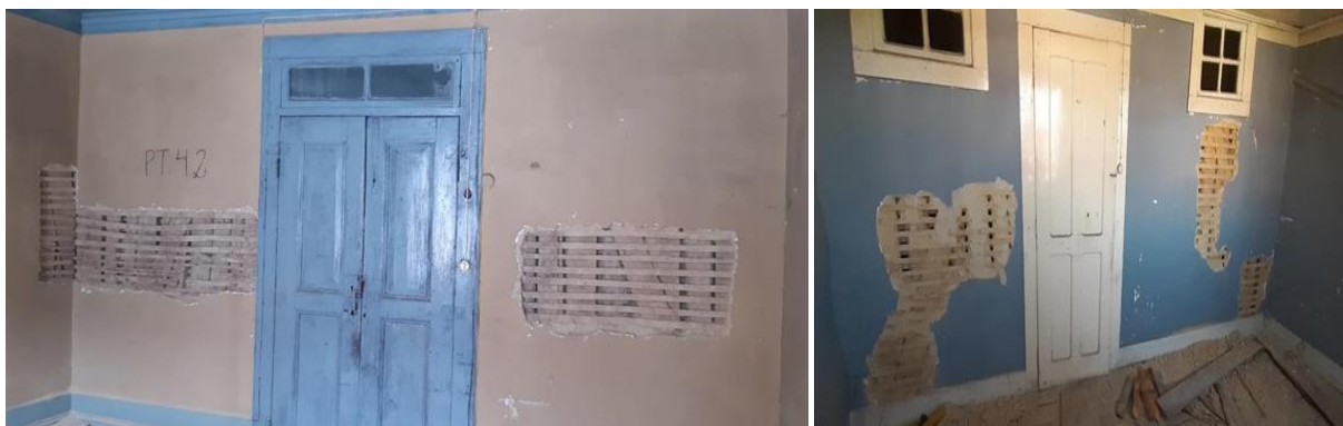
a) Parede de tabique do Piso 2
