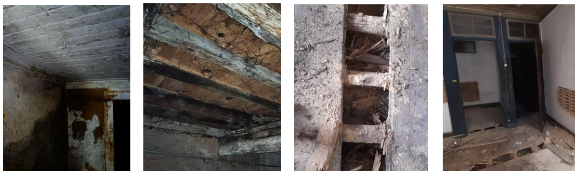
a) Vista da face inferior no 1.º compartimento b) Vista da face inferior nos restantes compartimentos c) Vista da face superior d) Vista geral do piso
