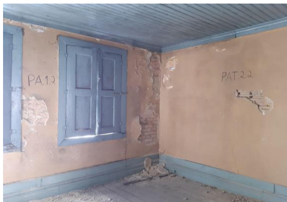
a) Parede do alçado principal em tijolo maciço
