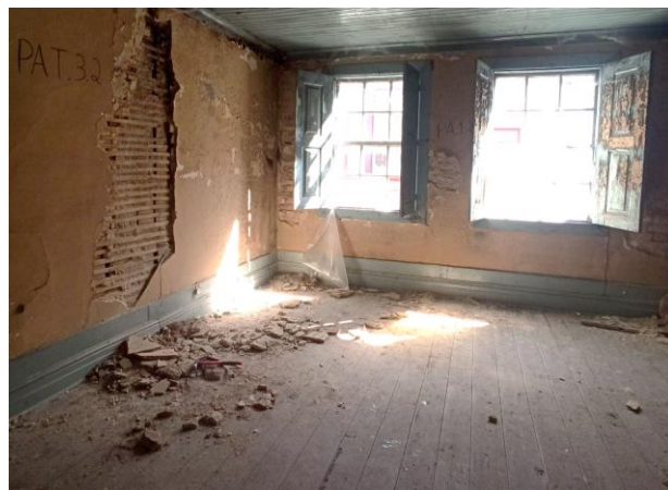
b) Parede PT 3.2
