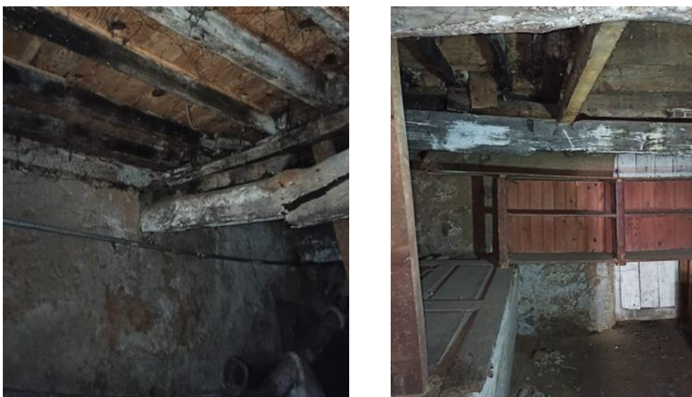
Figura 28: Paredes de alvenaria de pedra do Piso 0
