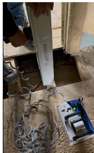
Figura 77: Realização do ensaio com Resistograph® em vigas
