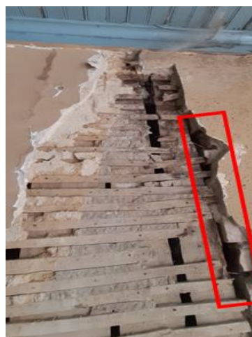
b) Ligação com 2 ligadores metálicos
