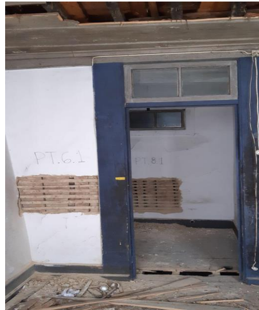
b) Parede interior de tabique
