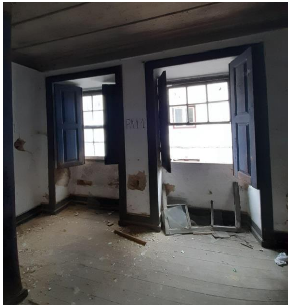
a) Parede exterior em pedra
