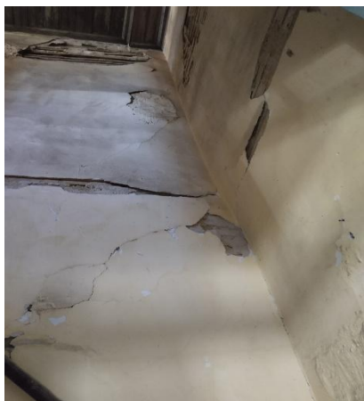
a) Caixa de escadas
