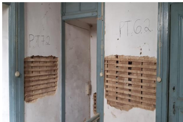
b) Parede interior de tabique
