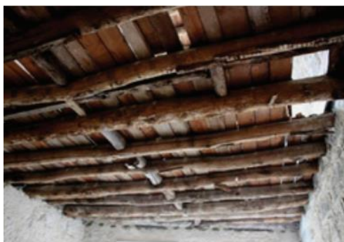
Figura 16: Pavimento de madeira de um edifício antigo de alvenaria. Vigas de secção transversal circular [17]
