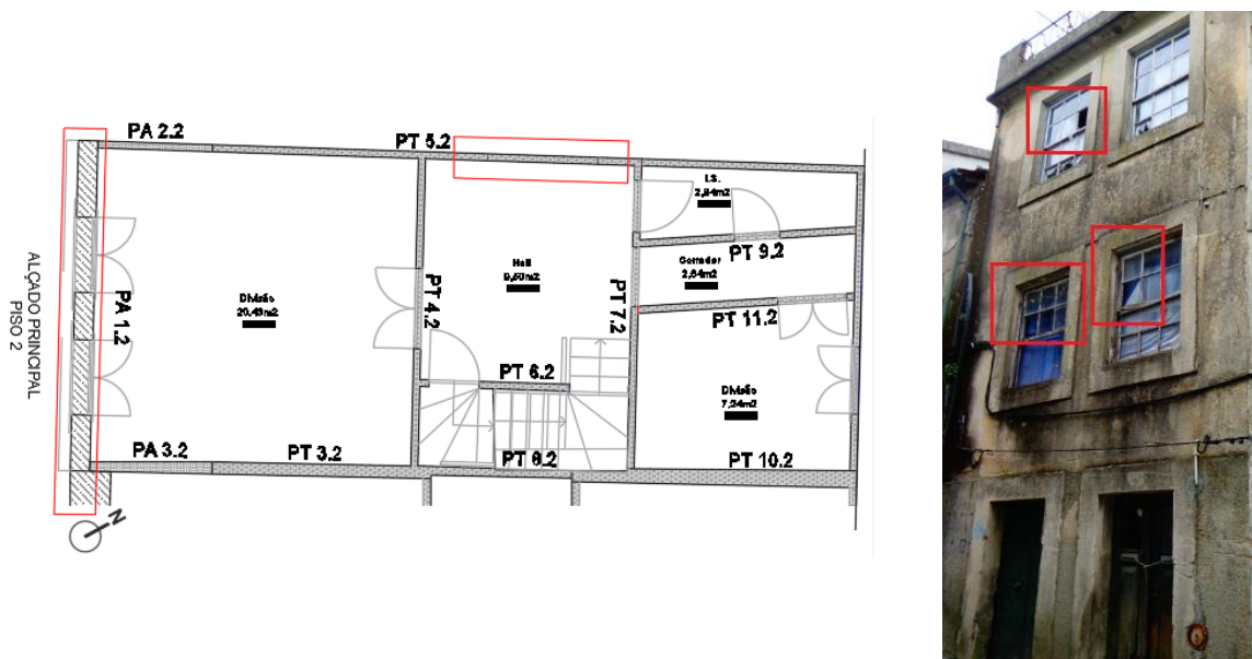
Figura 69: Localização dos vidros partidos – caixilharias
