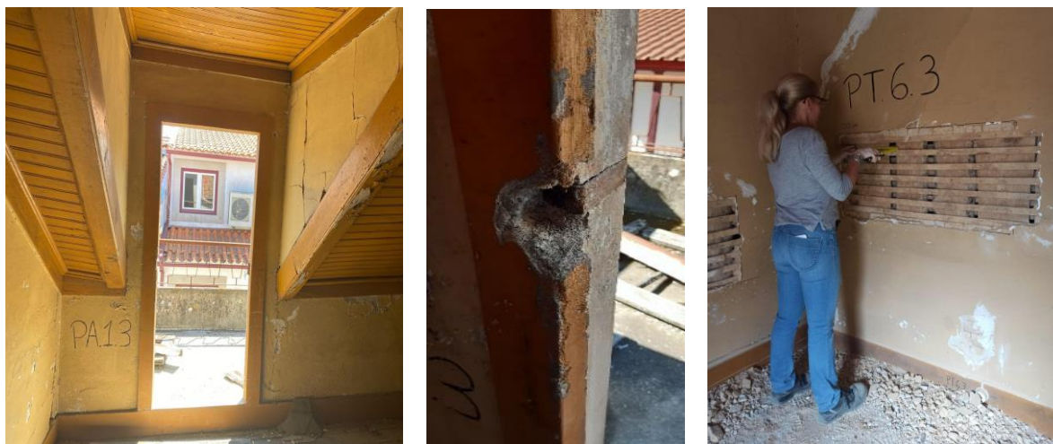
a) Parede do alçado principal em tijolo maciço
