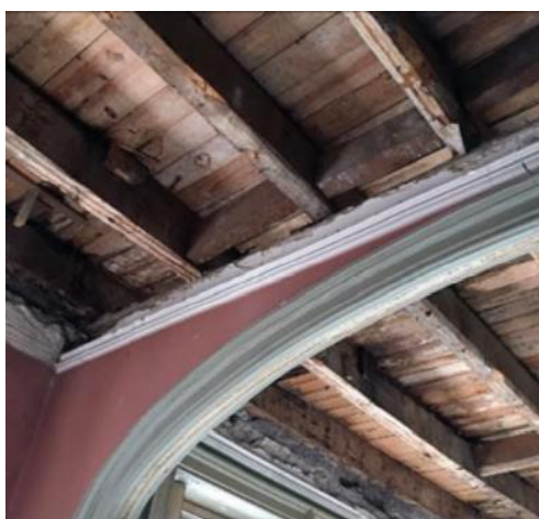
Figura 17: Pavimento de madeira de um edifício antigo de alvenaria. Vigas de secção transversal retangular [17]
