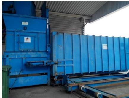
Figura 6-6 Prensa Fixa de Compactação do Centro de Tratamento Mecânico de RSU.
