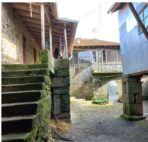
Figura 19 - Pátio de acesso às casas Castanheiro, Loureiro e Pinheiro
