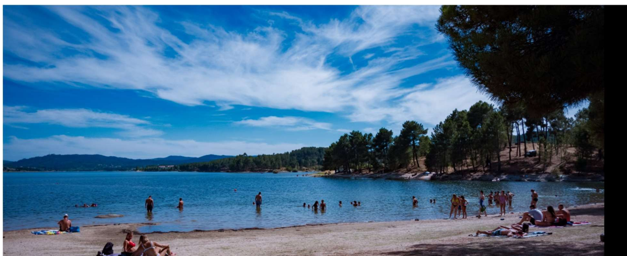
Figura 39 - Barragem do Vilar – Vista Geral
