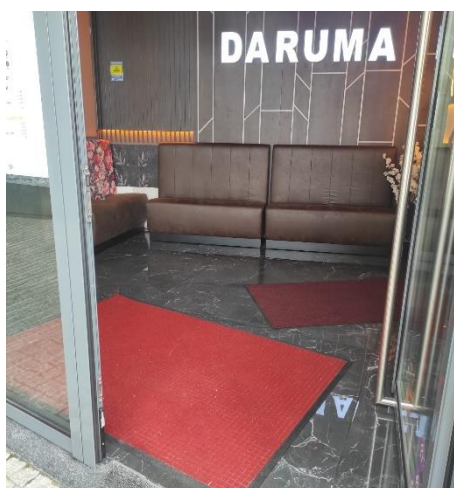
Figura 52 – Entrada sem desníveis Fonte: Autora
