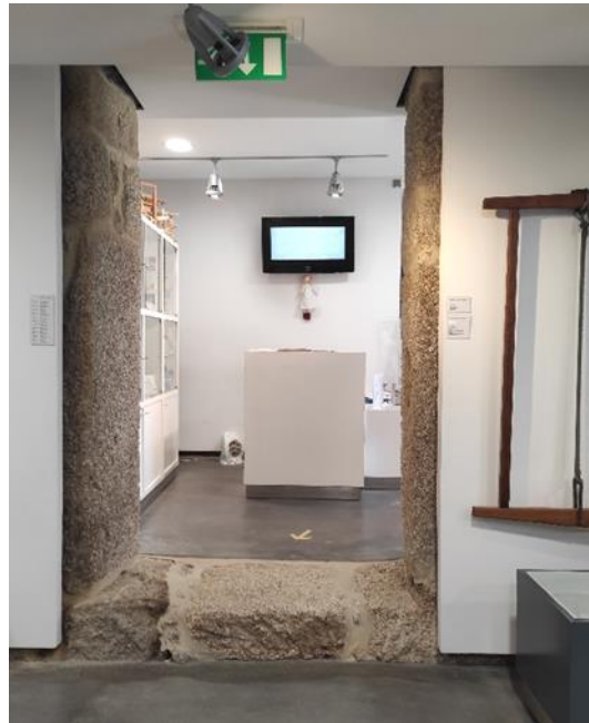
Figura 23 – Circulação entre salas sem rampa Fonte: Autora
