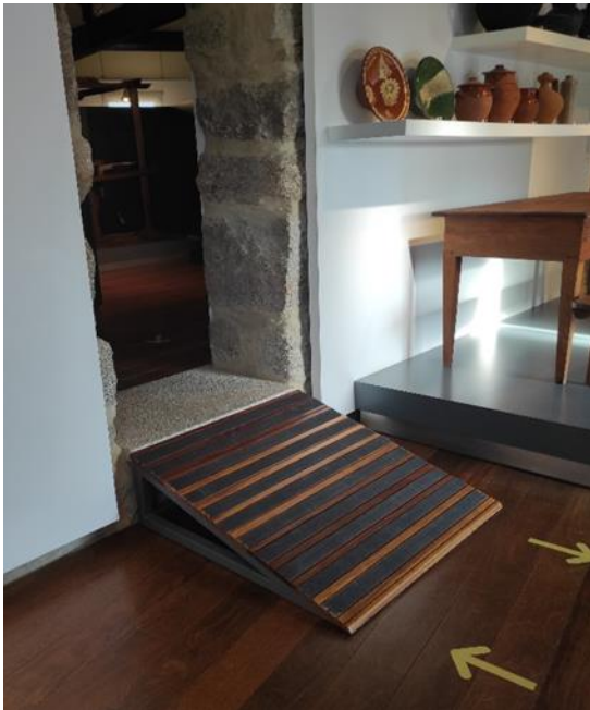
Figura 22 – Rampa com demasiada inclinação Fonte: Autora
