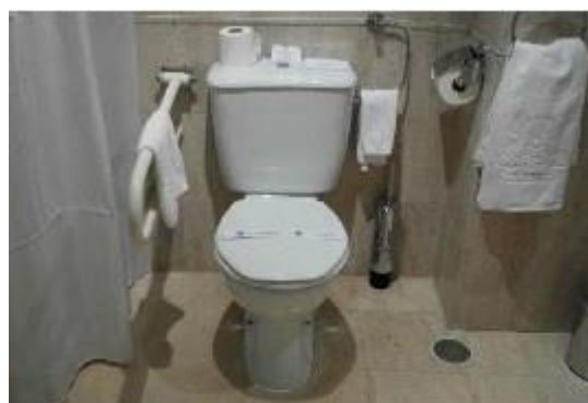
Figura 42 – WC do quarto adaptado Fonte: https://www.tur4all.com/pt
