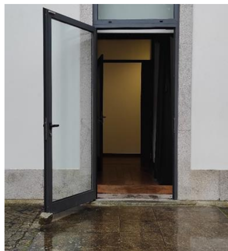
Figura 19 – Entrada secundária, acessível
