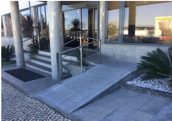
Figura 43 – Entrada principal com rampa Fonte: https://www.tur4all.com/pt
