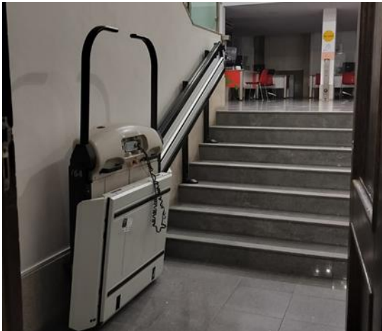
Figura 24 – Plataforma de acesso ao Atendimento Permanente Fonte: Autora
