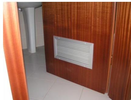
Grelha instalada nas portas da instalação sanitária e da cozinha.
