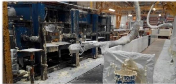
Figura 39: Zona de injeção
