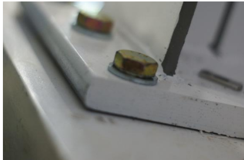
Figura 49 - Afastamento da placa da base em relação ao suporte (região sujeita à tracção).
