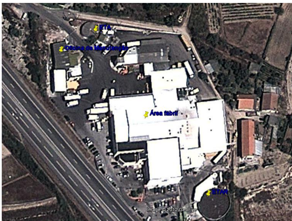
Figura 2: Vista aérea da unidade.
