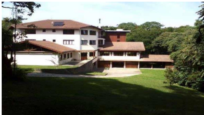
Figura 2 - Edificação estudada em Itaara. [14]
