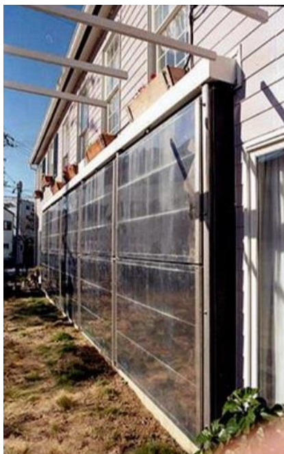
Figura 9 - Foto de uma Parede de Trombe [19]
