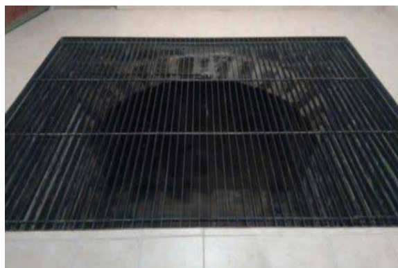
Figura 3 - Túnel de ar aberto no subsolo [14]
