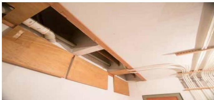
Figura 4 - Dutos para ventilação vertical [14]
