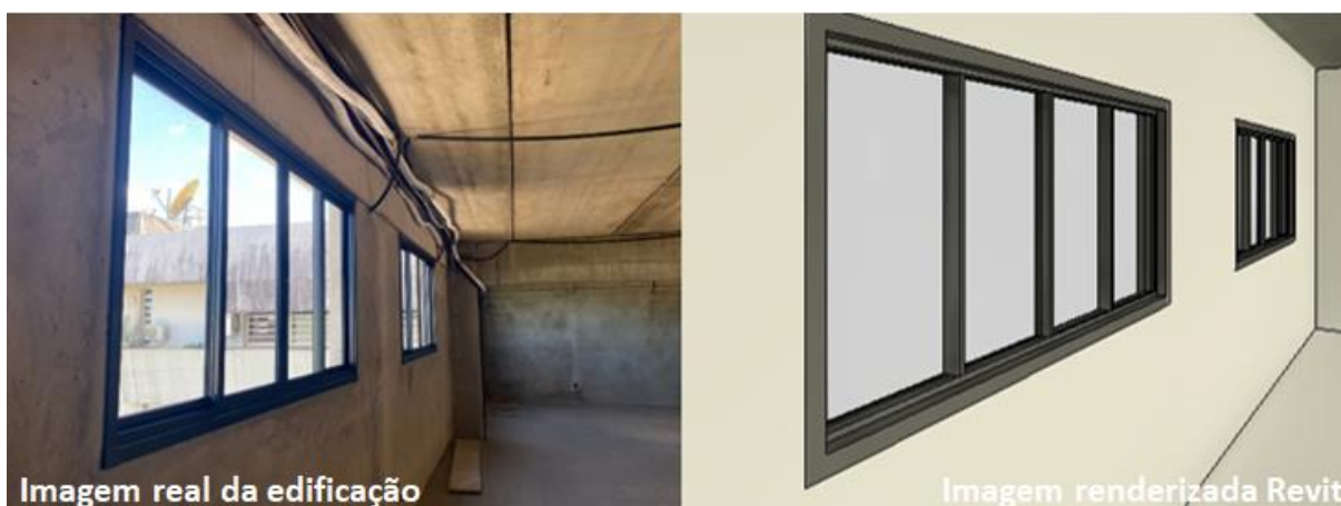
Figura 32: Janelas de correr com quatro folhas e caixilharia de alumínio anodizado Fonte: autoria própria (2022)
