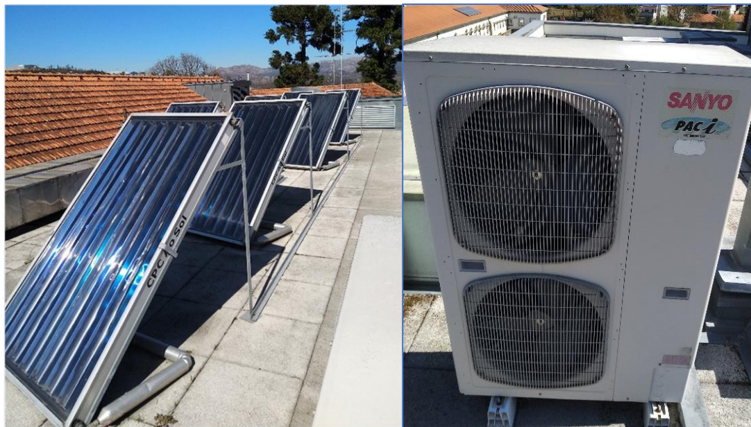
Figura 24 - Zona técnica terraço
