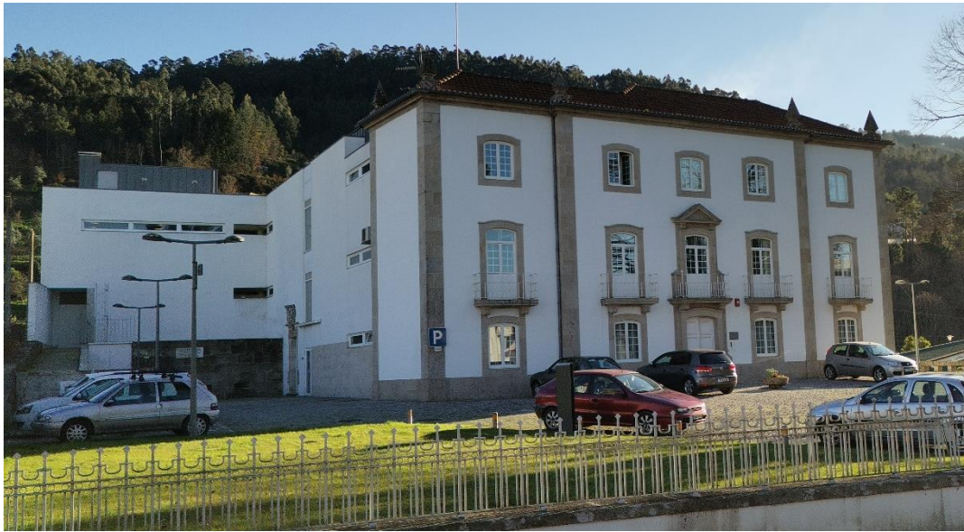
Figura 1 - Unidade de Cuidados Continuados Integrados da Santa Casa de Misericórdia de Vouzela
