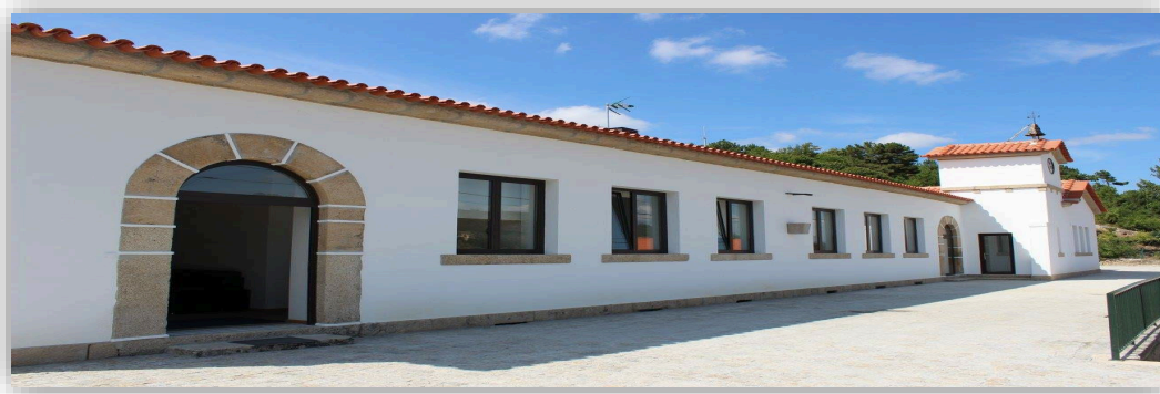
Figura 17 - Imagem exterior do CSPVS Fonte: “Elaboração própria, (2020)”
