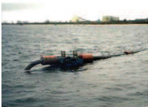
Figura 2-6: Deposição subaquática de rejeitados fora de estruturas de contenção adequadas (Engels, 2006)
