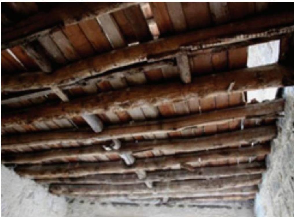
Figura 4 - Pavimento de madeira de uma construção antiga de alvenaria. Vigas de secção transversal circular (Ilharco et al., 2018)
