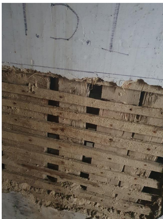
a) Fotografia da parede de tabique in situ
