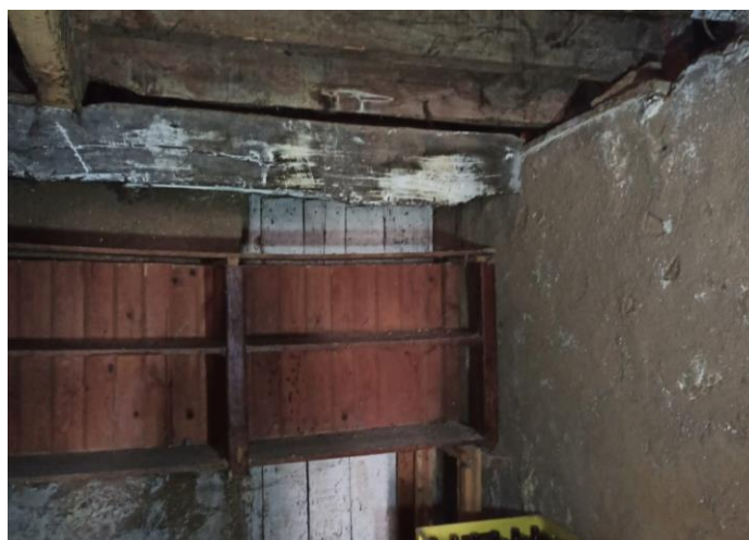
Figura 23 - Piso 0 com parede externa de alvenaria de pedra (Mendonça, 2023)
