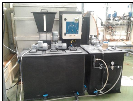
Figura IV.3.9. Unidades de preparação de polímero para o flotador e para a centrífuga.
