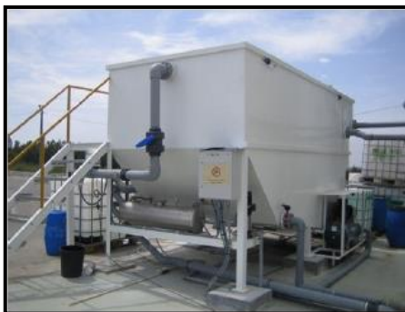
Figura IV.3.5. Tanque DAF.
