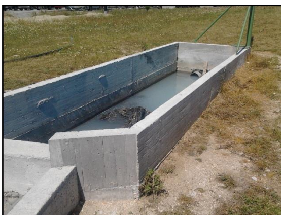
Figura IV.3.2. Tanque de entrada da ETARI (Tamisador).
