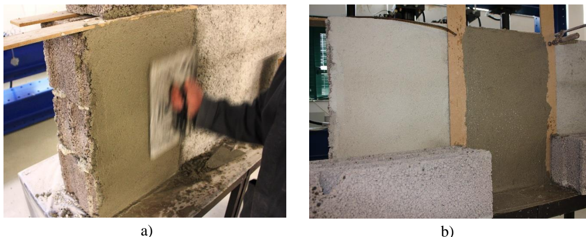
Figura 5-21: a) Alisamento da superfície com talocha; b) Colocação das régua de madeira
