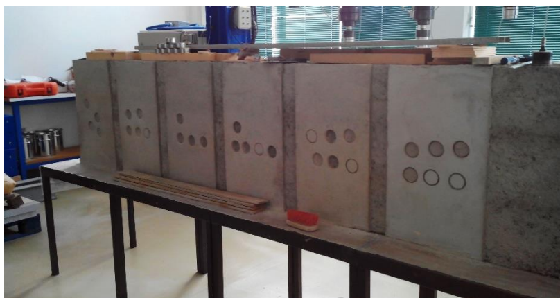
Figura 5-25: Aspeto final da parede após o ensaio
