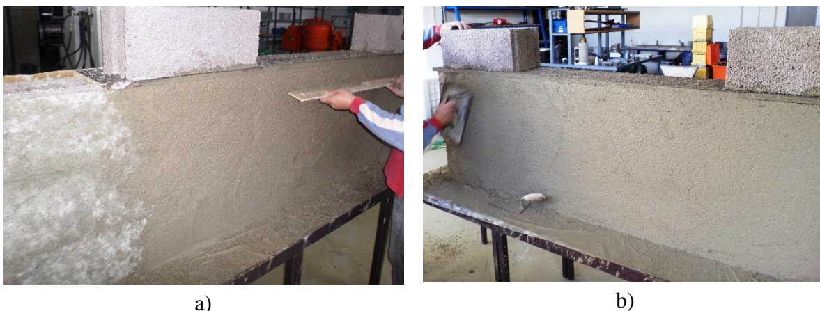
Figura 5-3: a) Eliminação do excesso de argamassa; b) Alisamento da superfície com talocha
