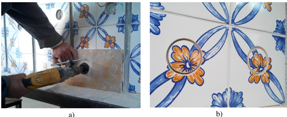
Figura 5-11: a) Execução do pré-corte; b) Aspeto após o pré-corte
