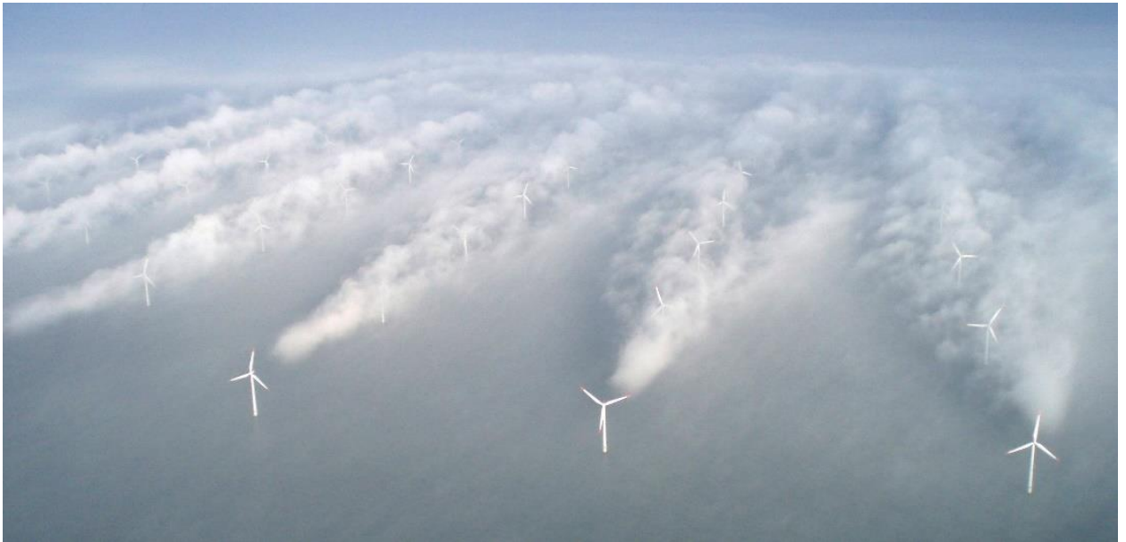
Figura 8 - Efeito esteira criado pelas turbinas tradicionais [15].
