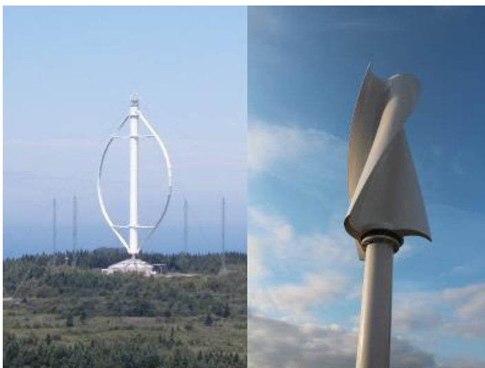
Figura 18 - Turbinas de eixo vertical Darrieus (esquerda) e Savonius (direita). Fonte: [21].
